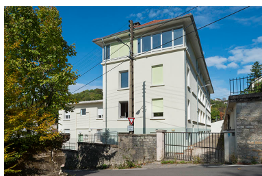
Pignon ouest et façade postérieure. Phot. Jérôme Mongreville IVR43_20172501133NUC4A
