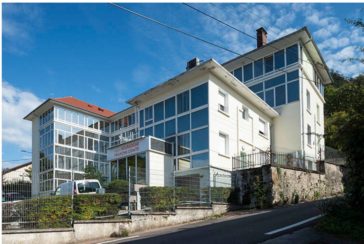
Vue de trois quarts depuis le chemin des Ragots.
