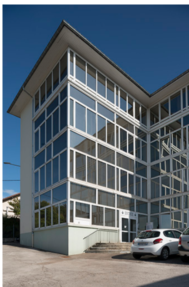
Extension est (1956). Phot. Jérôme Mongreville IVR43_20172501135NUC4A
