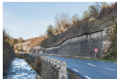
Viaduc et mur de soutènement, depuis l'est.
