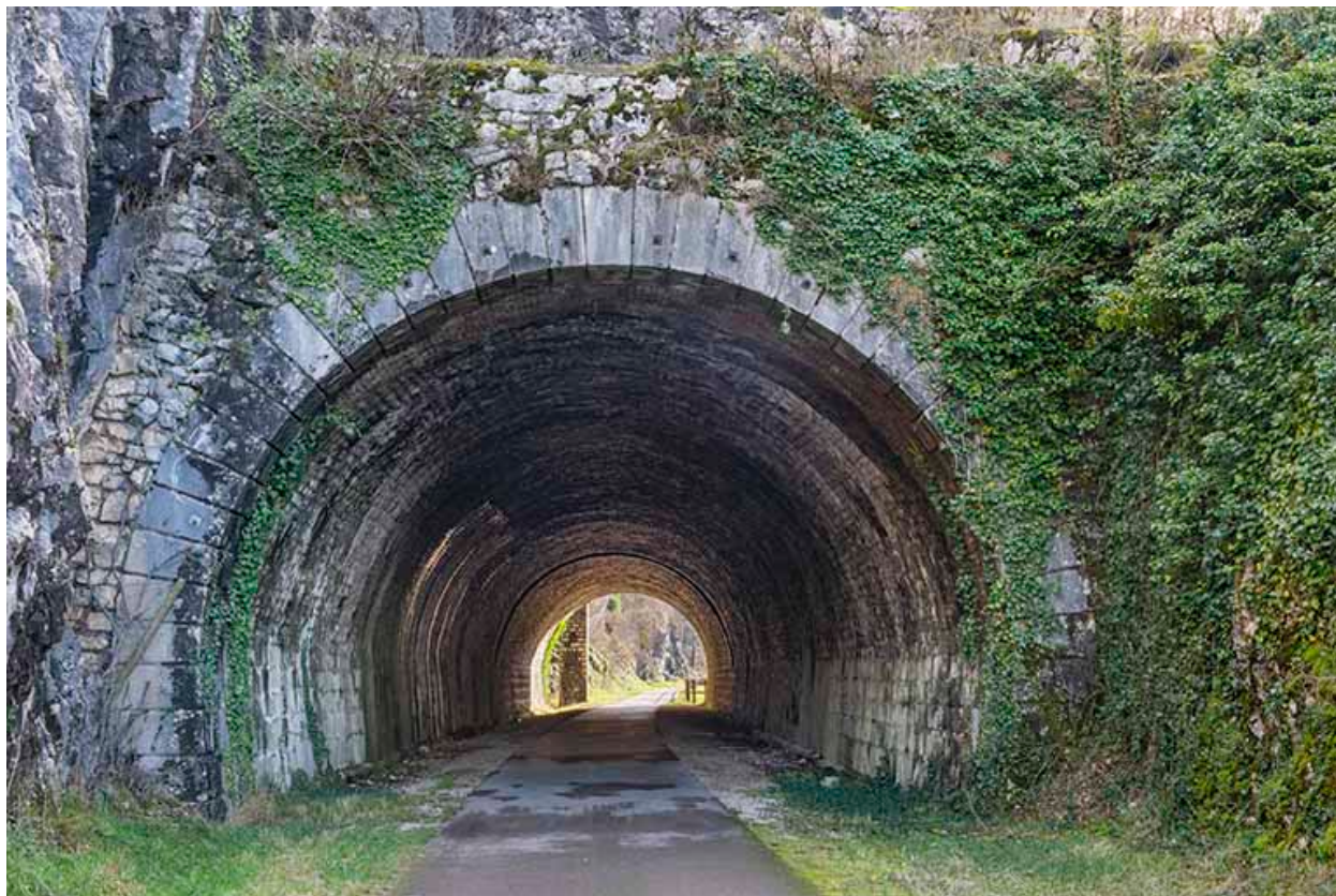
Entrée ouest du tunnel.
