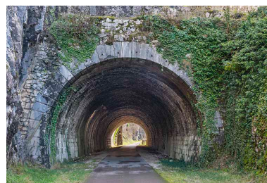
Entrée ouest du tunnel.
