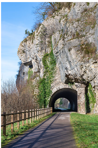
Vue du tunnel depuis l'est.
