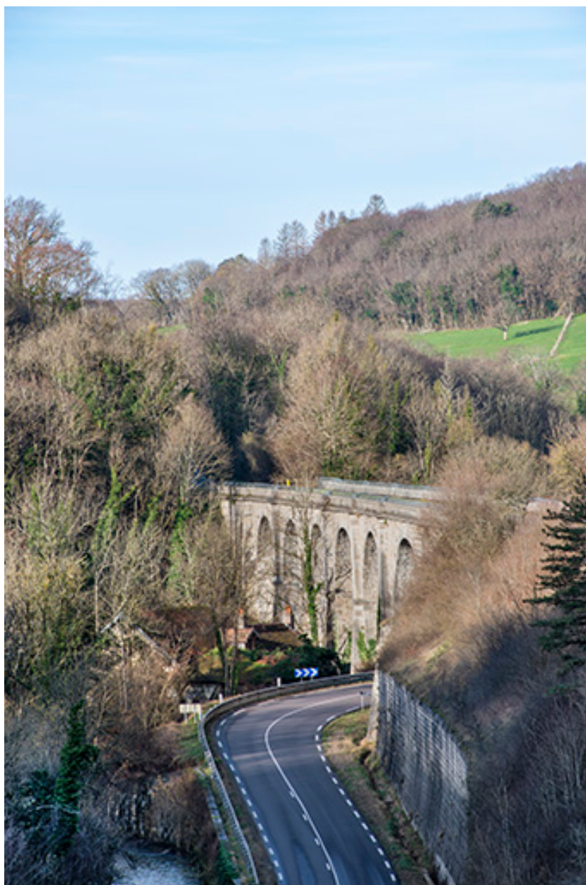
Vue rapprochée du viaduc, depuis l'est.
