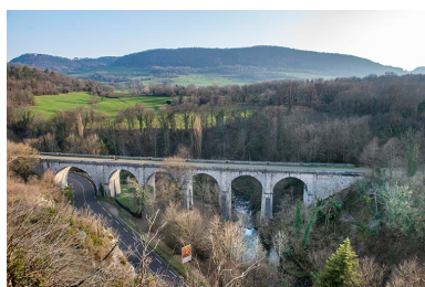
Vue du viaduc depuis le nord-ouest.
