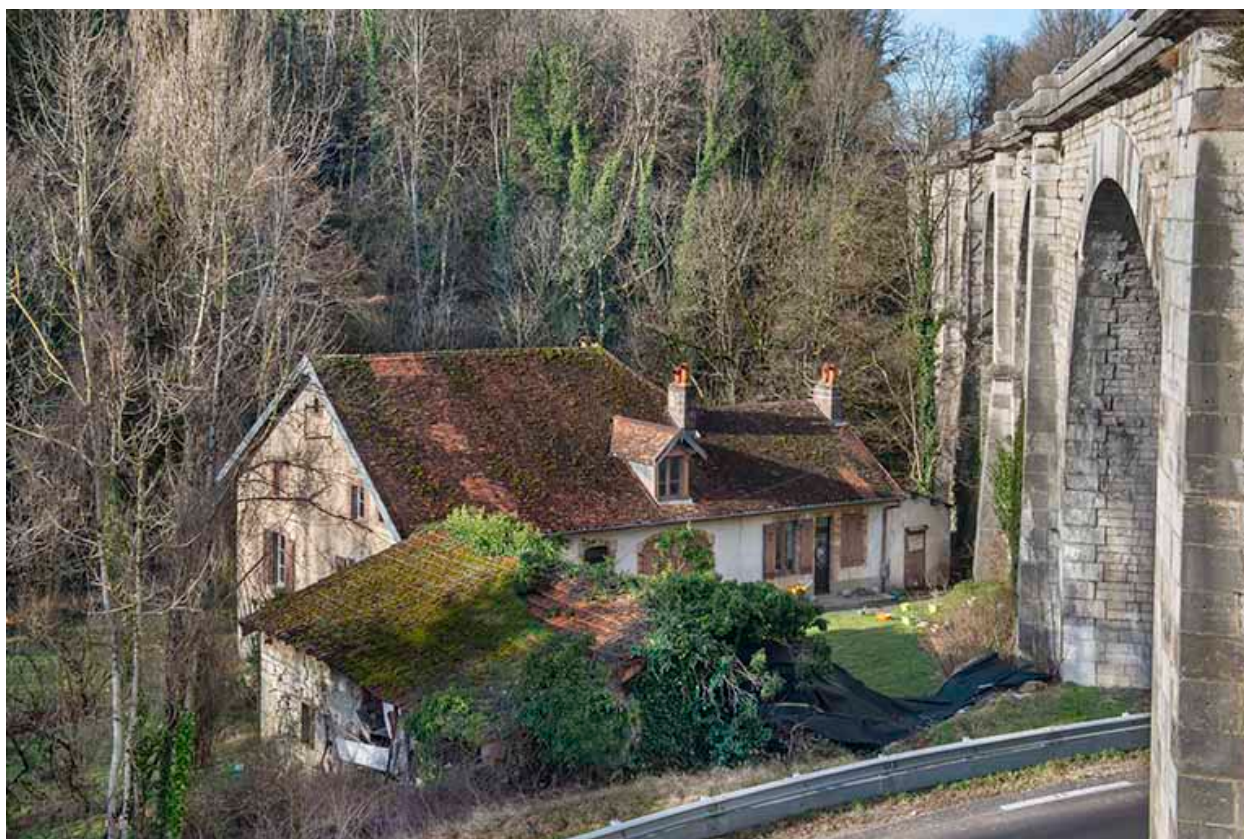
Virage et viaduc, vus de trois quarts.
