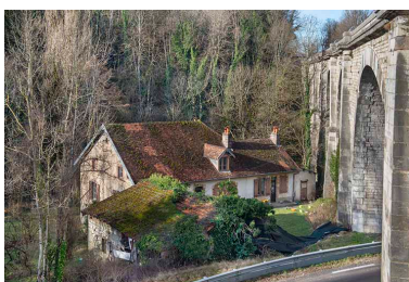
Virage et viaduc, vus de trois quarts.
