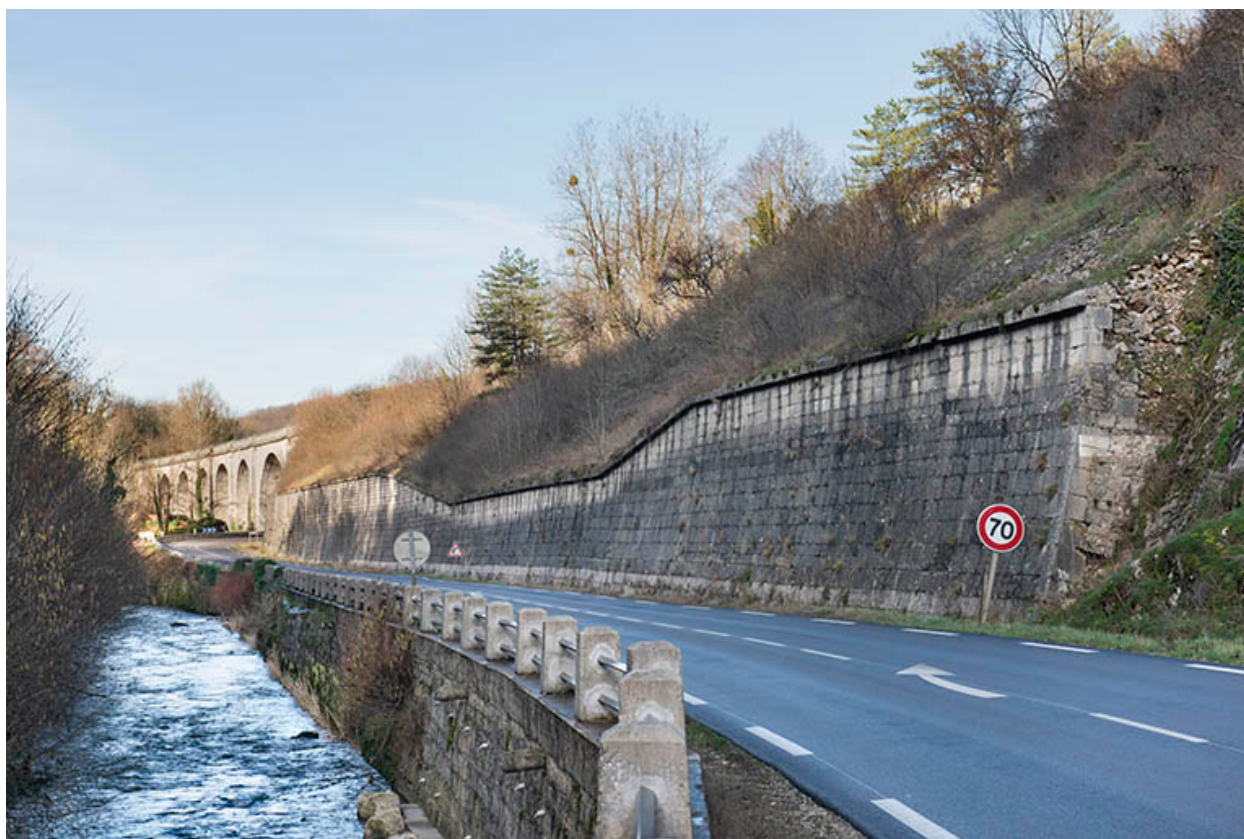
Viaduc et mur de soutènement, depuis l'est.
