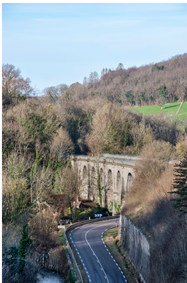
Vue rapprochée du viaduc, depuis l'est.
