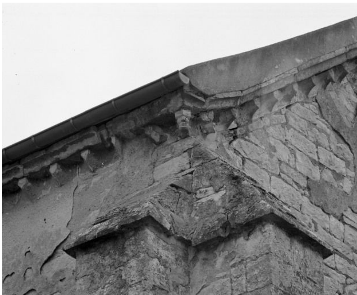
Façade : détail de l'angle gauche du pignon.
