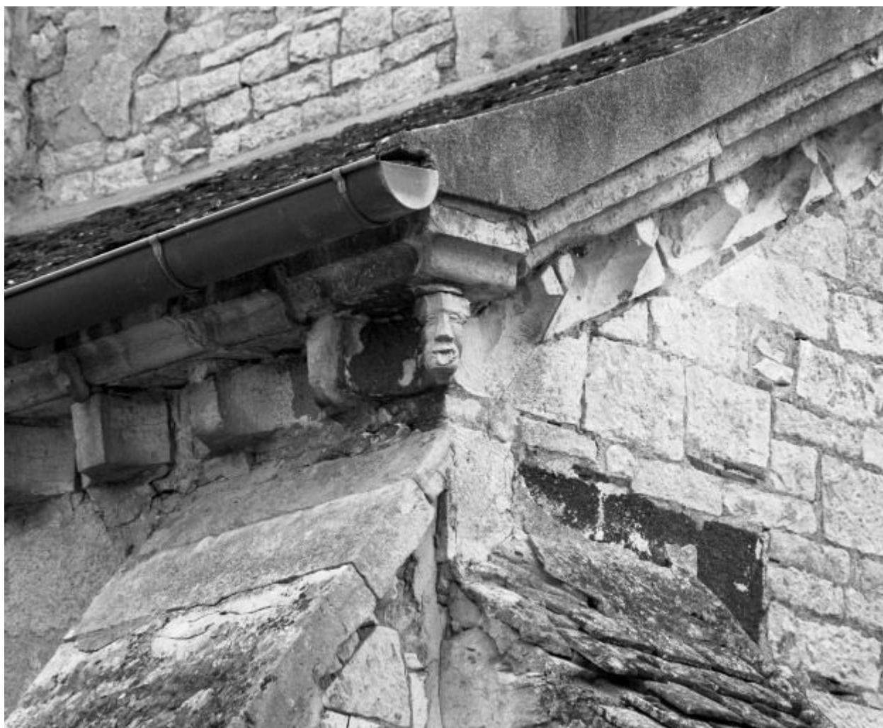
Façade : détail de l'angle du bas-côté gauche.
