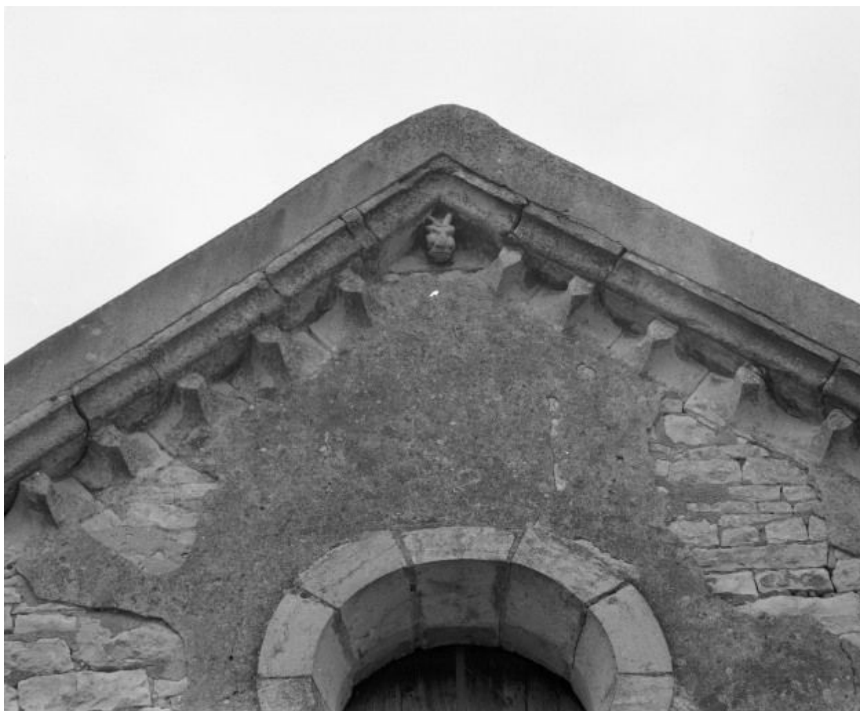
Façade : détail du pignon.
