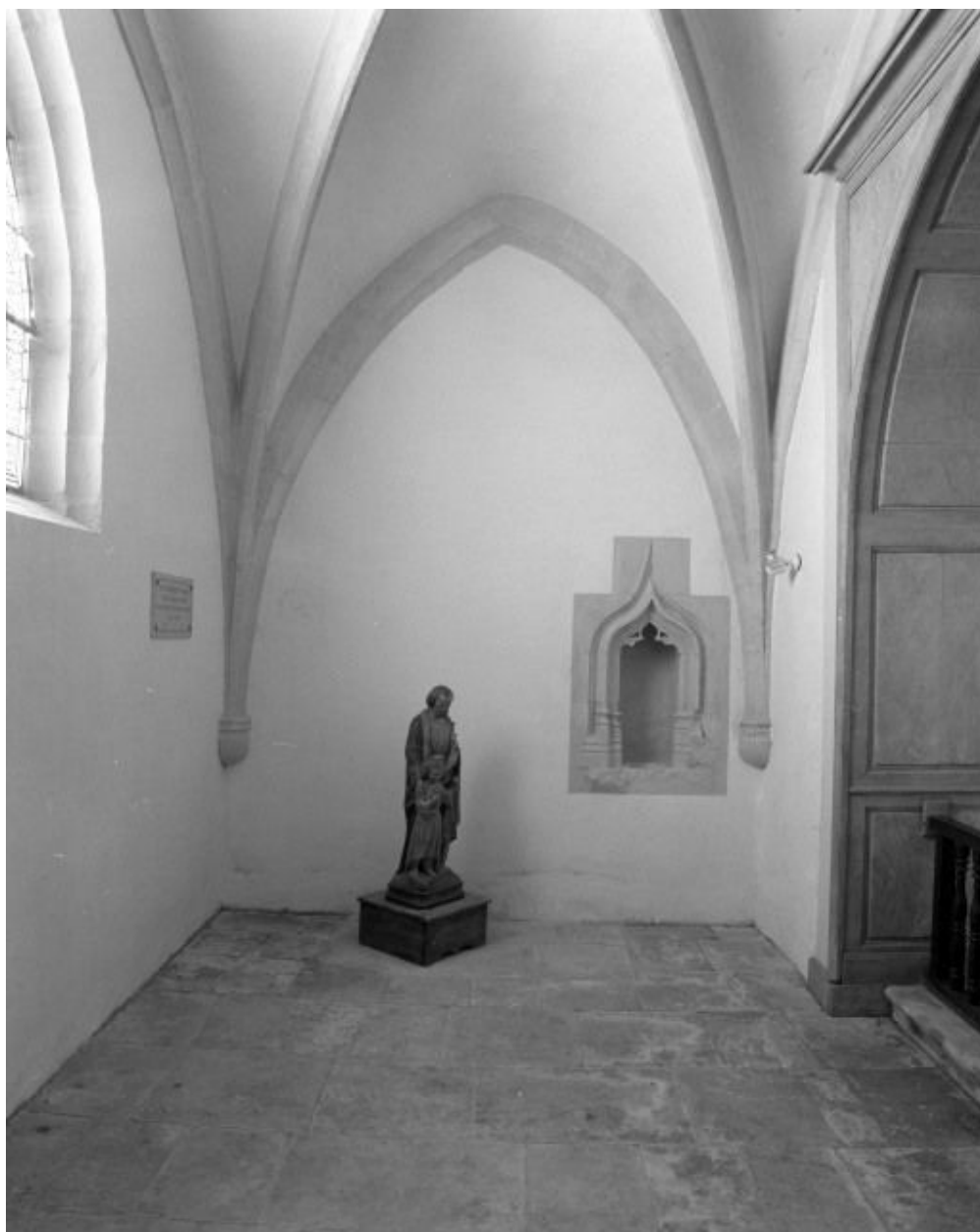
Chapelle gauche du choeur, partie postérieure.
