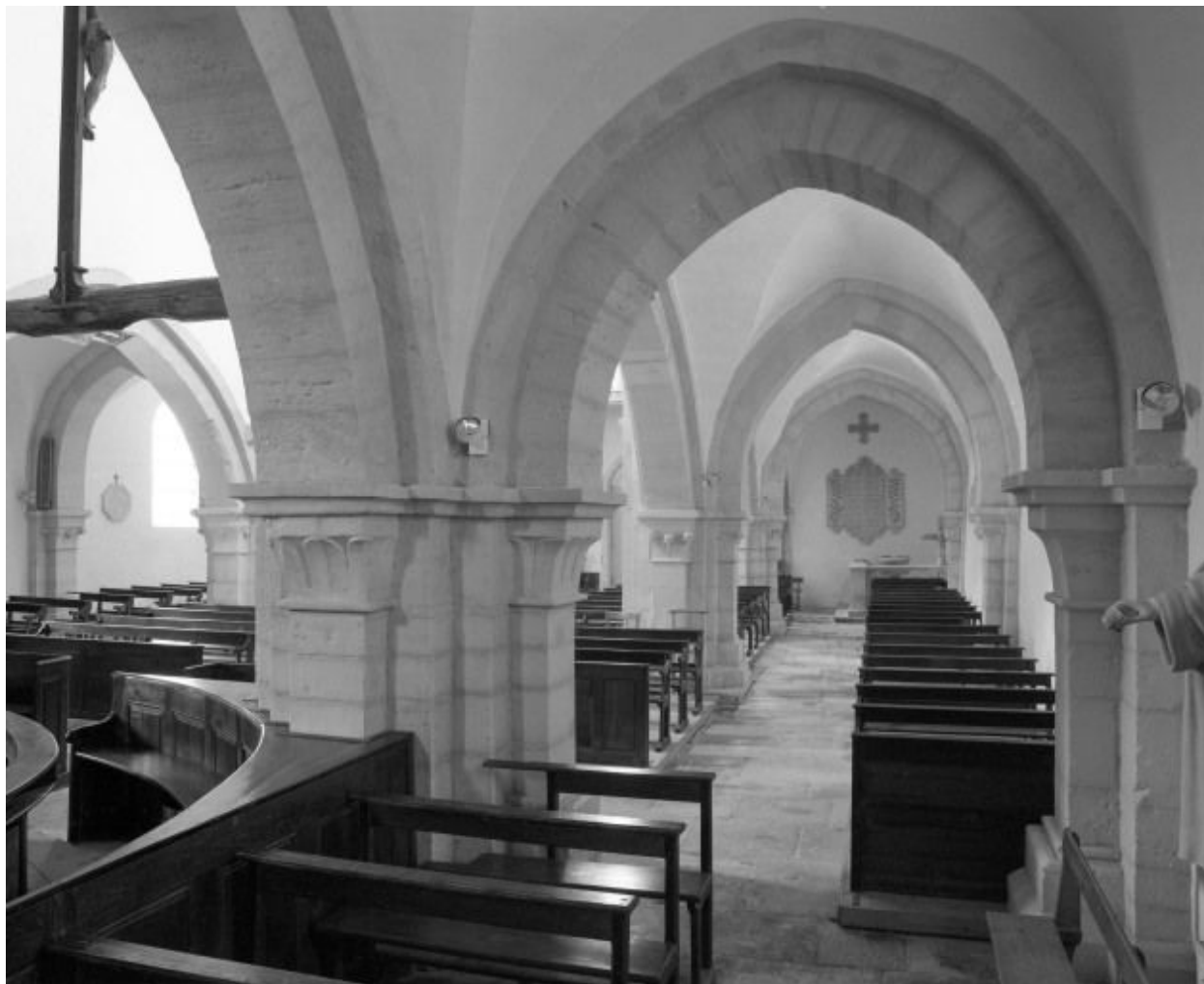
Bas-côté gauche, vue depuis sa chapelle.
