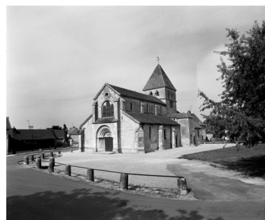
Vue d'ensemble : façade et élévation droite.
