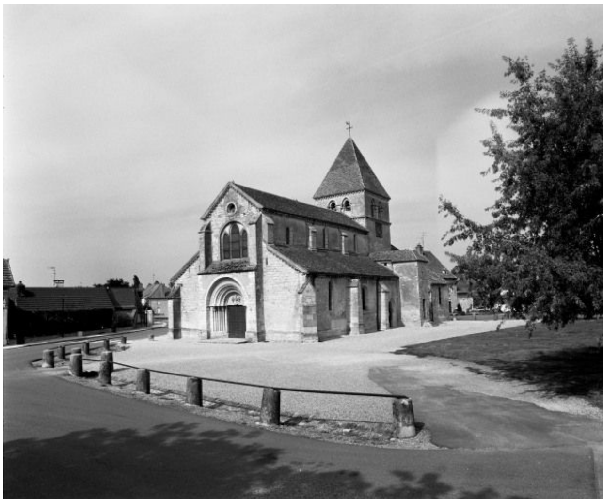
Vue d'ensemble : façade et élévation droite.
