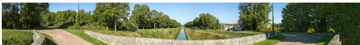
Vue panoramique de la tranchée.
