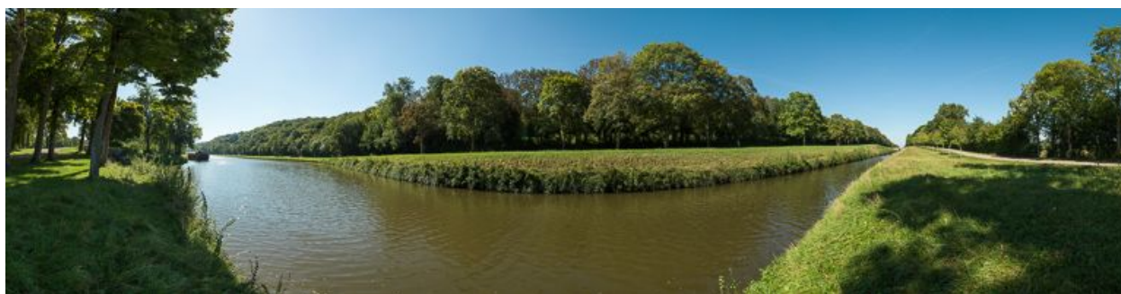
Panorama de l'entrée de la tranchée.
