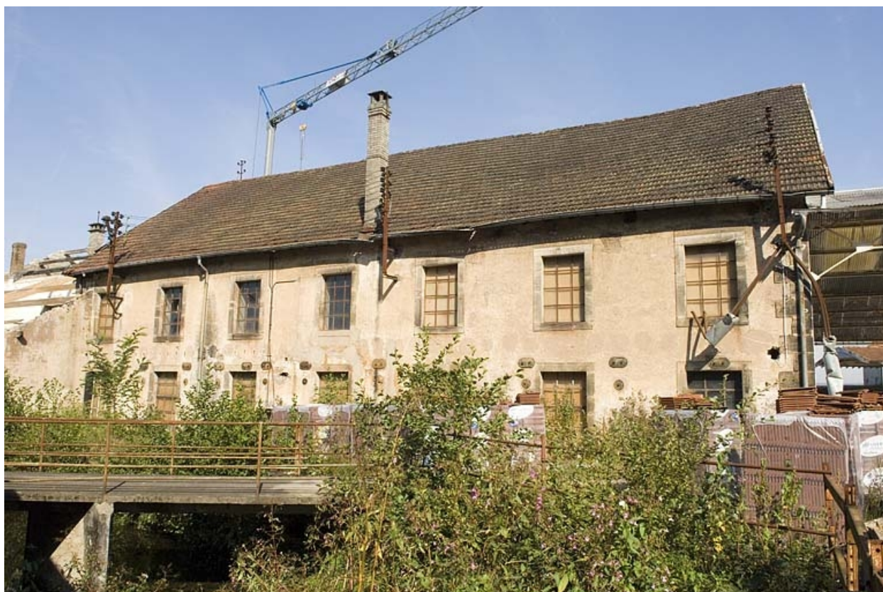
Façade sud de l'atelier de fabrication.
