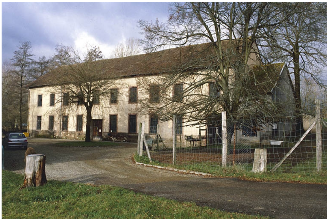
Façade antérieure de l'atelier de fabrication.
