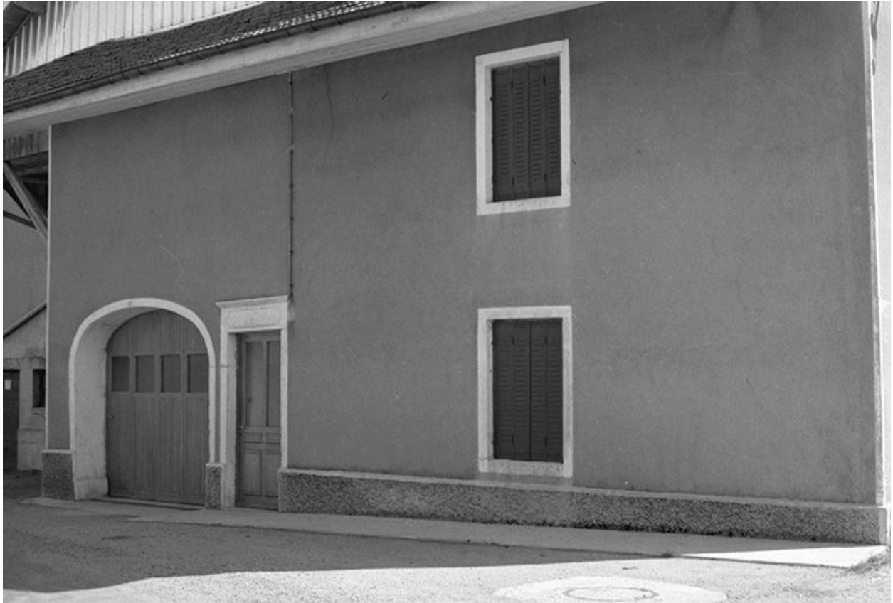
Ferme de 1809, cadastrée 1967 AB 28 : façade antérieure.
