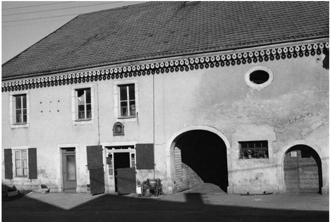
Ferme de 1865, située 12 Grande Rue : façade antérieure.
