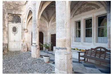
Détail de la galerie Phot. Jérôme Mongreville IVR43_20137000400NUCA
