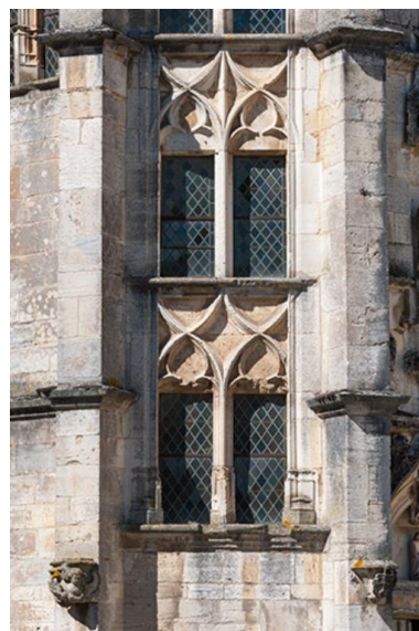
Détail des baies de la tour d'escalier Phot. Jérôme Mongreville IVR43_20137000368NUCA
