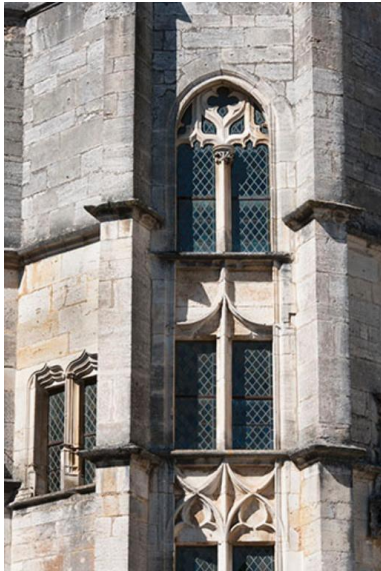
Détail des baies de la tour d'escalier Phot. Jérôme Mongreville IVR43_20137000369NUCA
