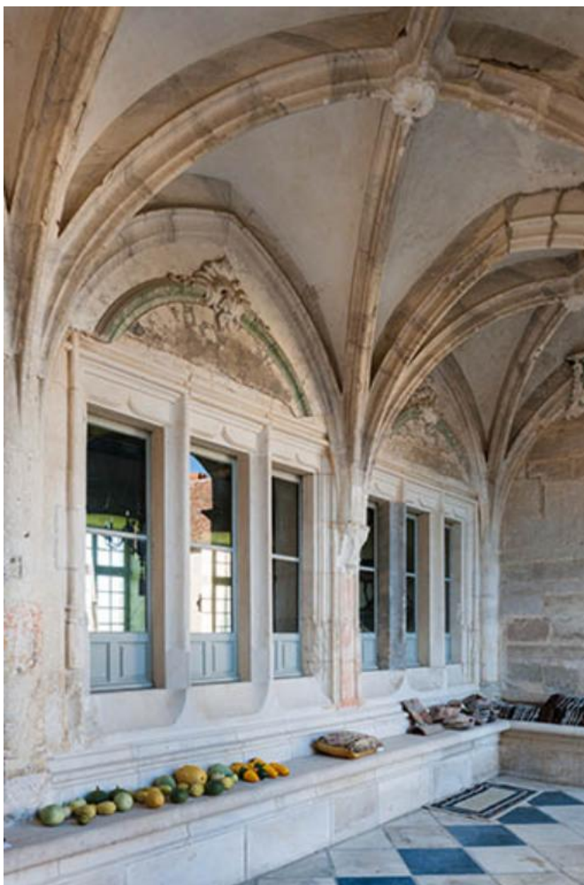
Baies situées au fond de la galerie
