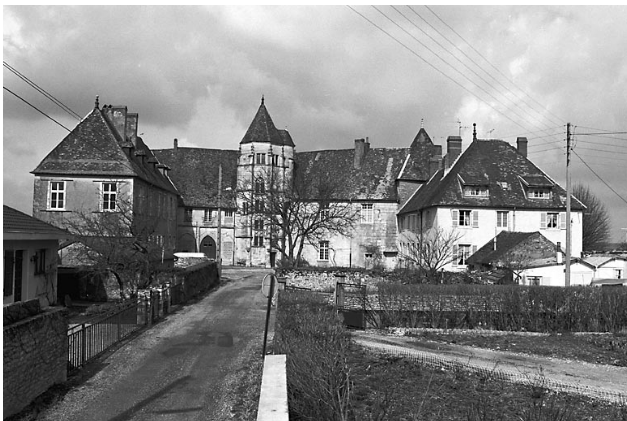
Façade antérieure sur cour
