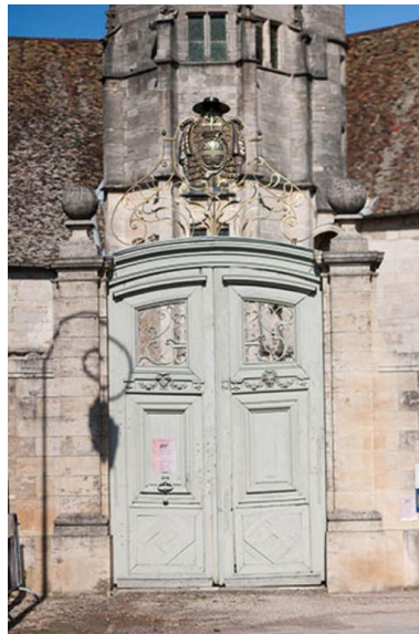
Le portail d'entrée Phot. Jérôme Mongreville IVR43_20137000411NUCA
