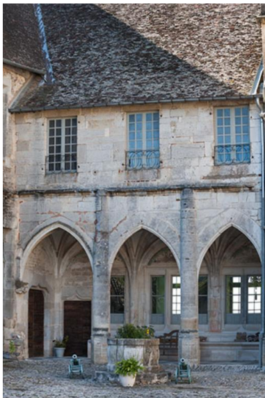
Les arcs brisés de la galerie Phot. Jérôme Mongreville IVR43_20137000408NUCA
