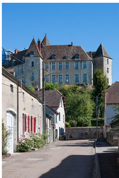
Vue nord, depuis la rue des Terreaux Phot. Jérôme Mongreville IVR43_20137000175NUCA
