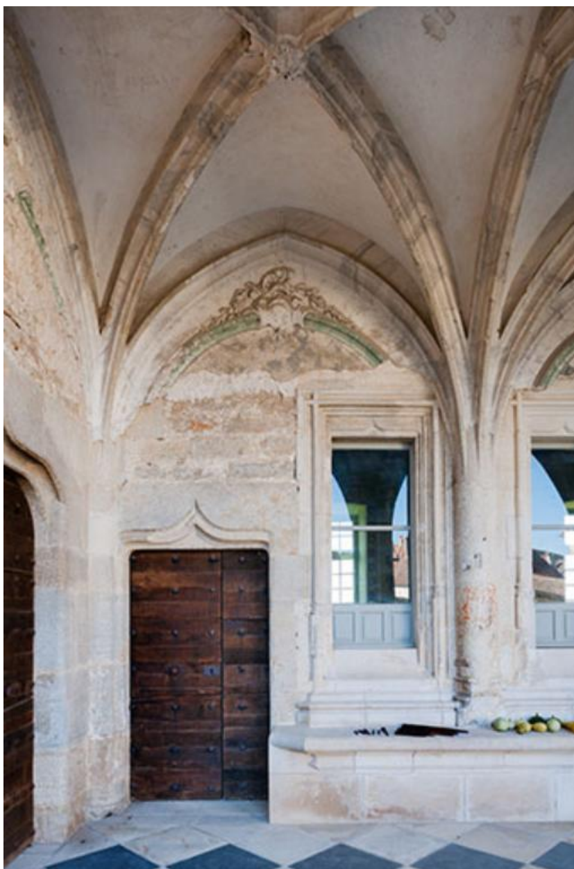
Baies situées au fond de la galerie
