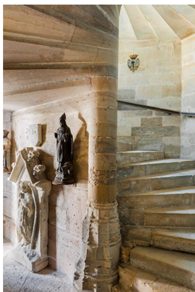
L'escalier en vis Phot. Jérôme Mongreville IVR43_20137000405NUCA
