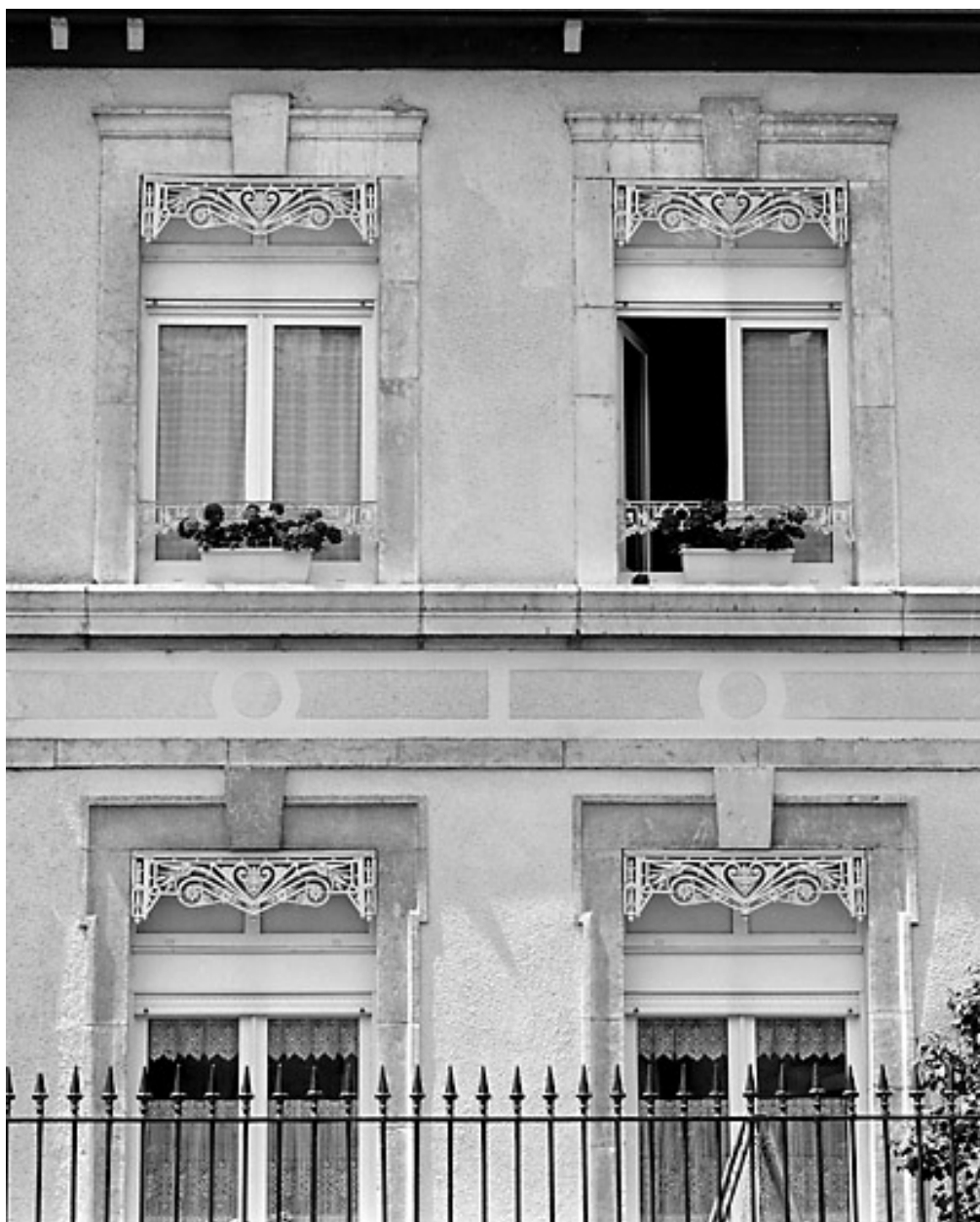
Elévation antérieure : baies.
