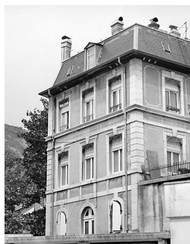
Elévation postérieure. Phot. Yves Sancey IVR43_20033900116X
