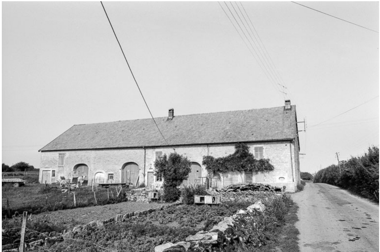
Ferme cadastrée A3 552 : façade antérieure et jardin.
