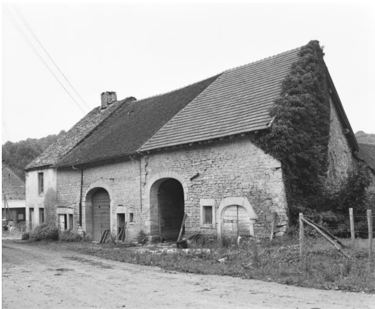
Ferme située au lieudit Binans : vue d'ensemble.
