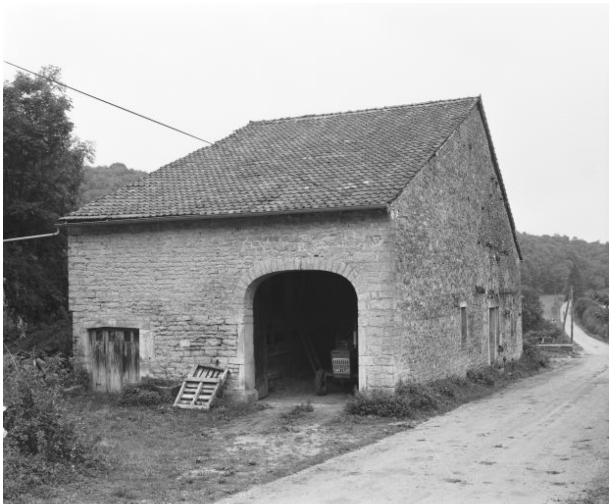
Ferme située au lieudit Binans : vue d'ensemble.
