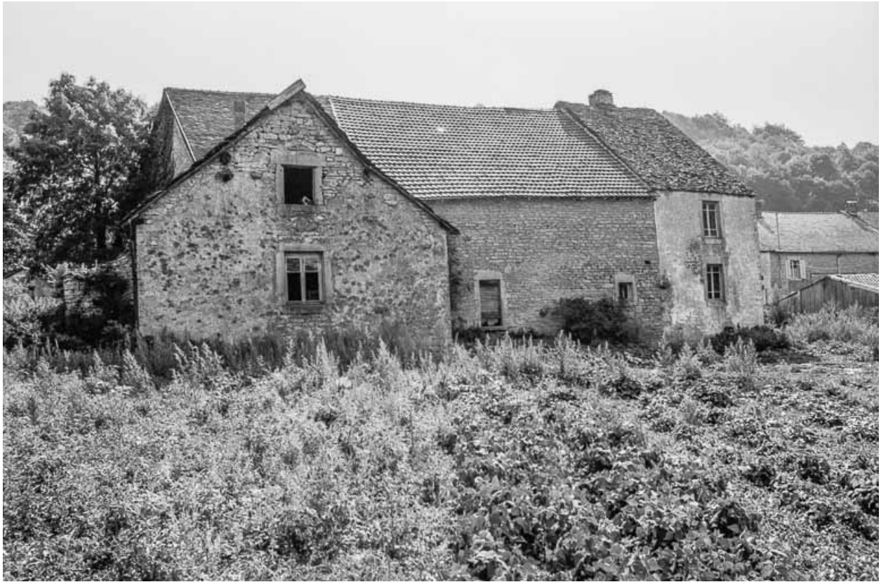
Ferme cadastrée ZK 40 : façade postérieure.
