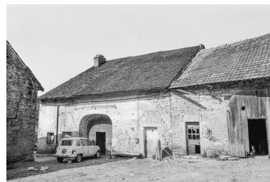
Ferme cadastrée ZK 40 : façade postérieure. Phot. Bernard Pontefract IVR43_19763900335Z
