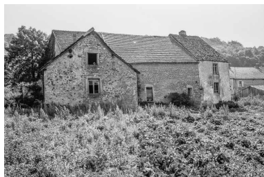
Ferme cadastrée ZK 40 : façade postérieure. Phot. Bernard Pontefract IVR43_19763900337Z
