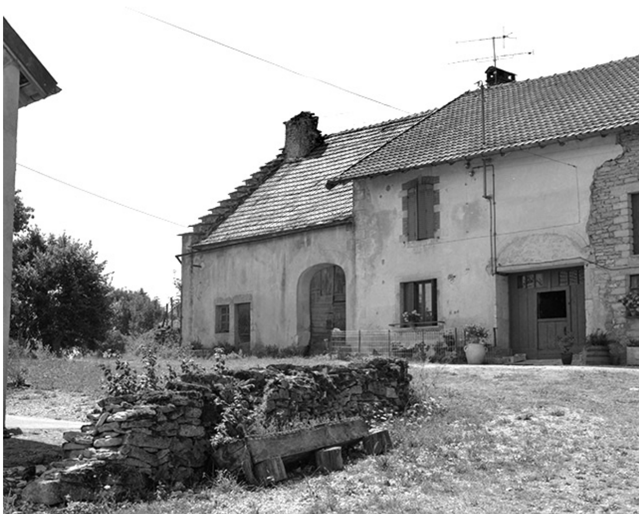
Ferme située dans la rue "La Ruelle" : façade antérieure.
