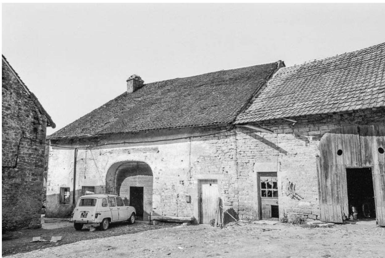
Ferme cadastrée ZK 40 : façade postérieure.
