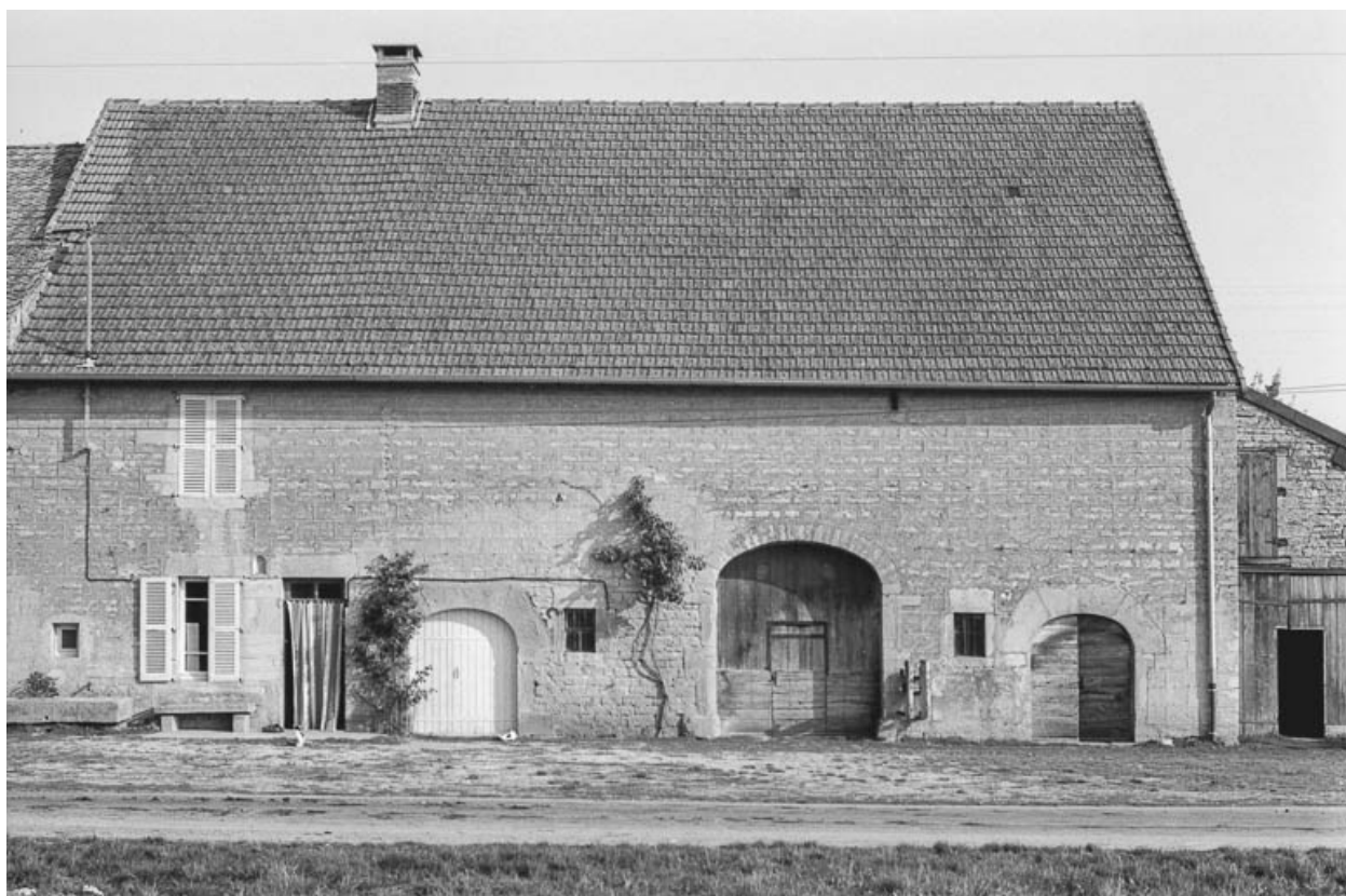
Ferme cadastrée A3 564 : façade antérieure.
