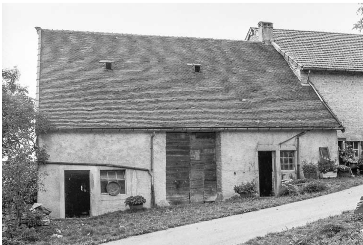
Ferme cadastrée A3 447 : façade antérieure.
