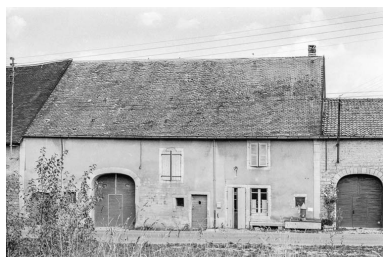
Ferme située rue des Trois Fontaines : façade antérieure. Phot. Bernard Pontefract IVR43_19763900310Z
