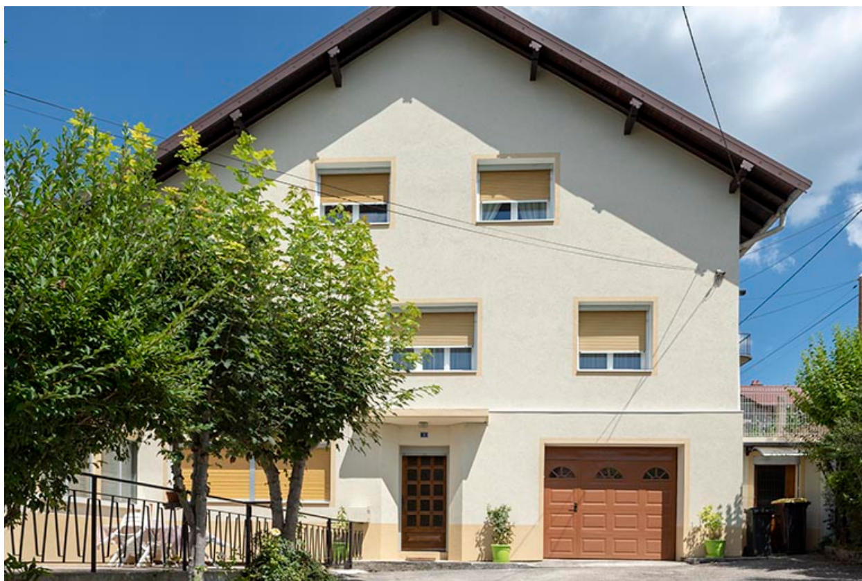
Maison : façade antérieure.
