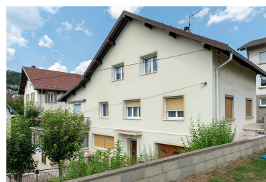
Maison, vue de trois quarts droite. Phot. Sonia Dourlot IVR43_20182501225NUC4A
