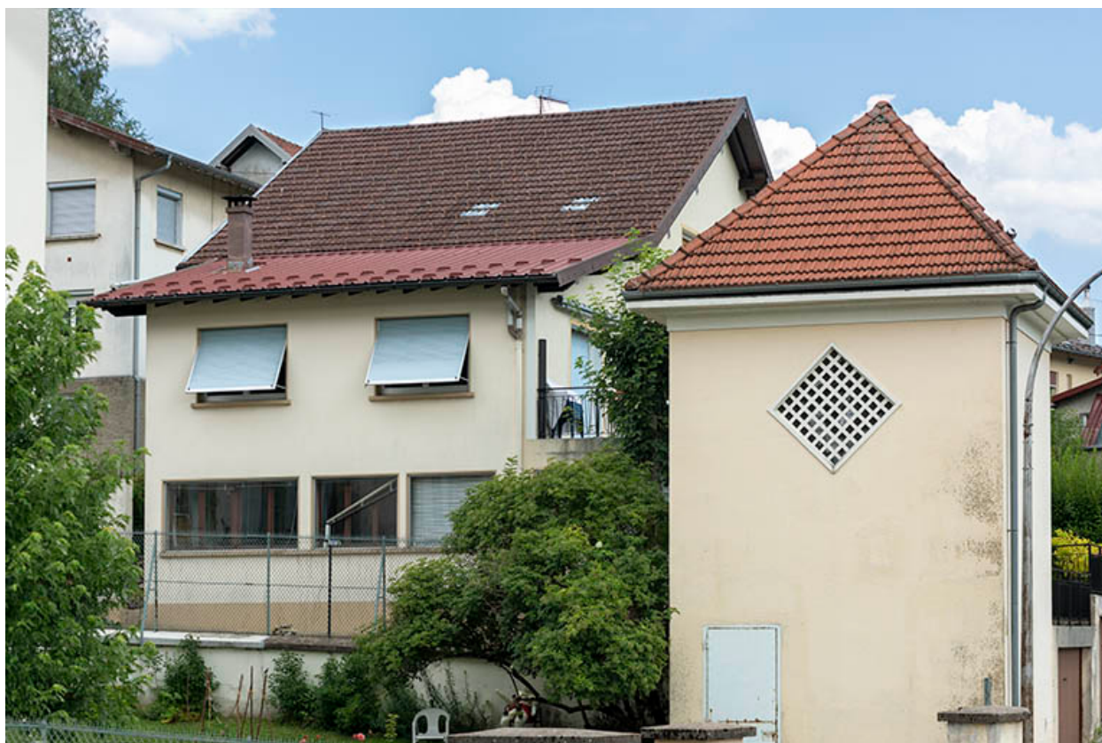
Extension occidentale avec atelier.
