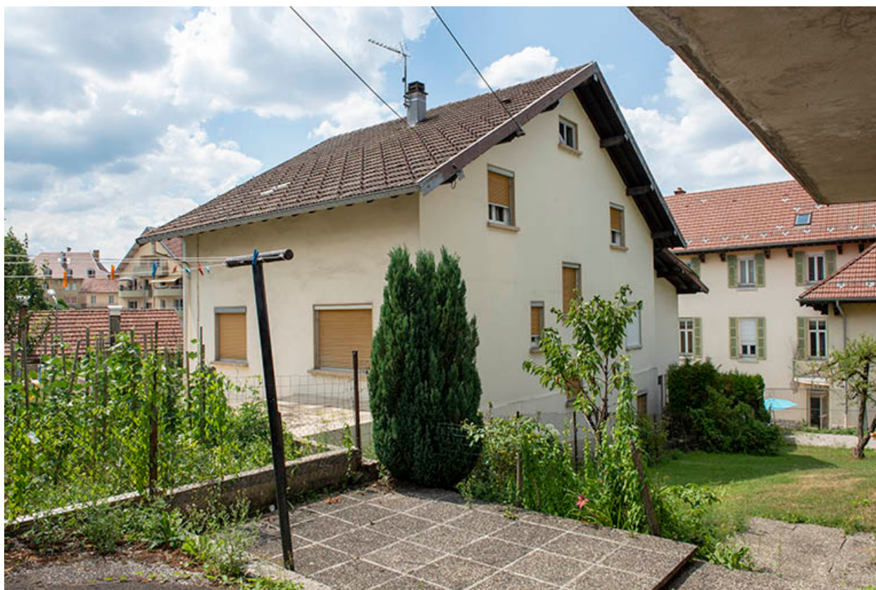
Maison : façades postérieure et latérale droite.
