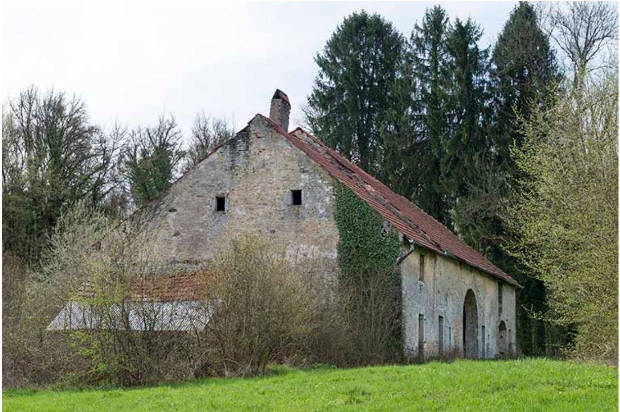
Le mur pignon nord.
