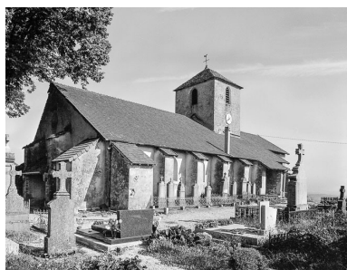
Façade latérale gauche et chevet Phot. Yves Sancey IVR43_19783900079V
