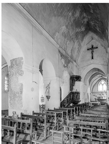
Intérieur : nef, élévation gauche. Phot. Yves Sancey IVR43_19783900082V
