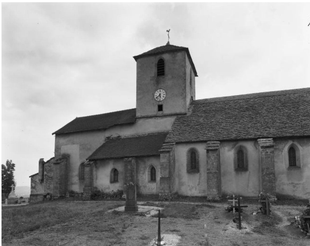
Façade latérale gauche.
