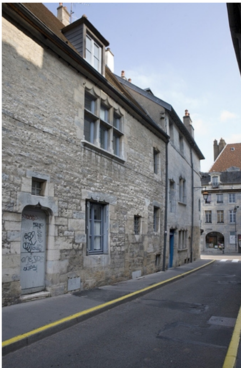
Façade latérale gauche : vue partielle.
