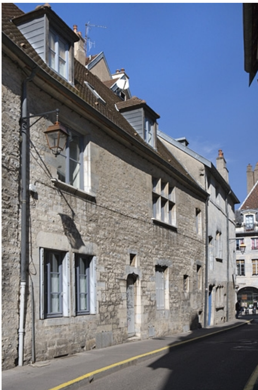
Façade latérale gauche, vue partielle.
