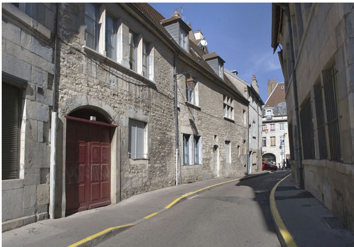
Façade latérale gauche, vue d'ensemble.
