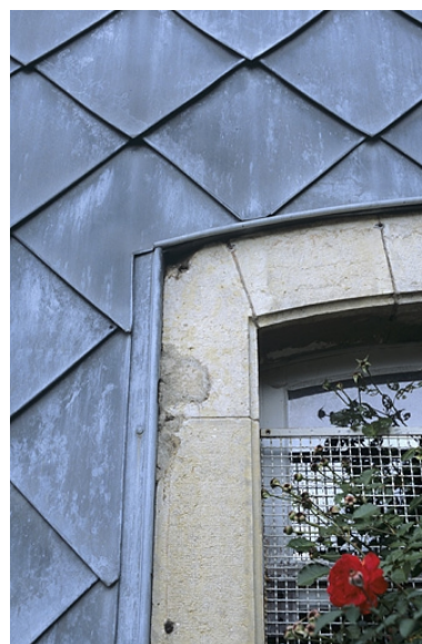
Bâtiment des voyageurs : détail de l'essentage de tôle de l'élévation latérale sud. Phot. Yves Sancey IVR43_20043900221ZA
