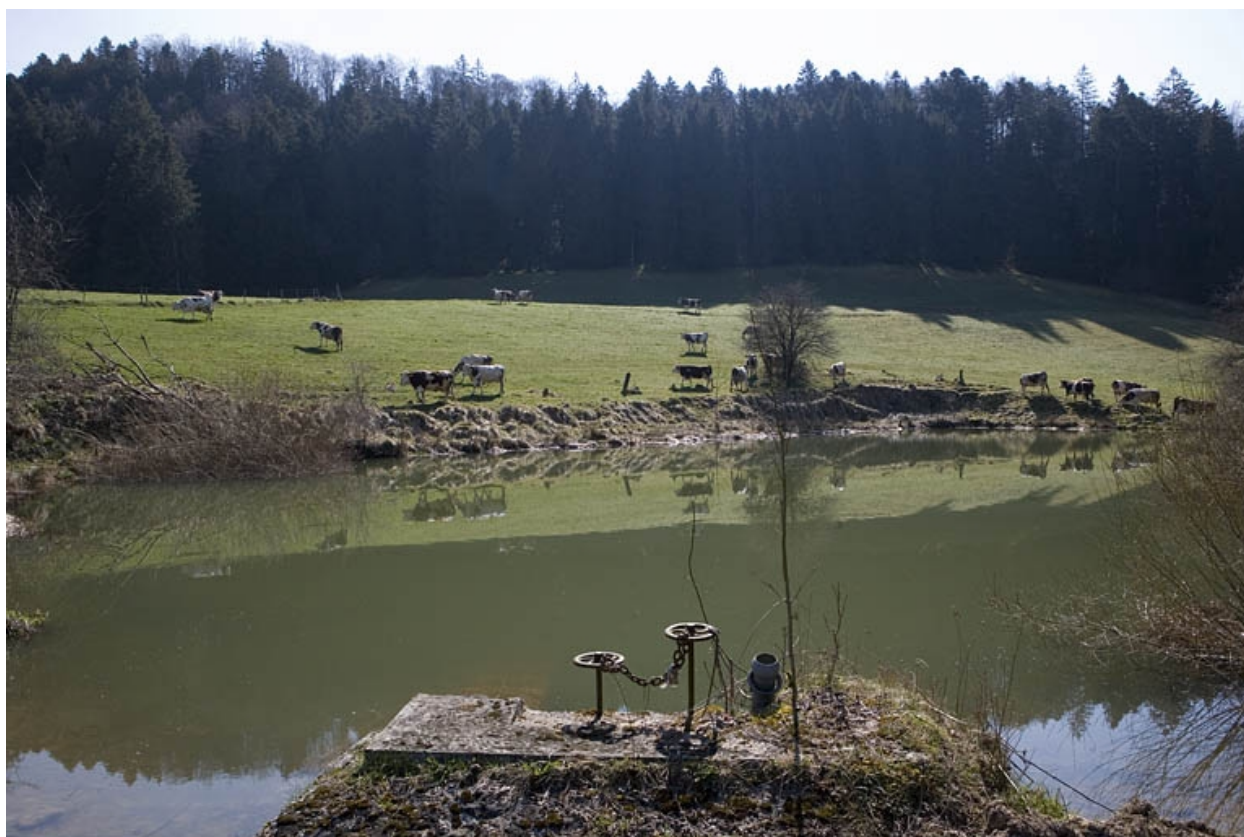
Réservoir : vue d'ensemble, depuis l'ouest.
