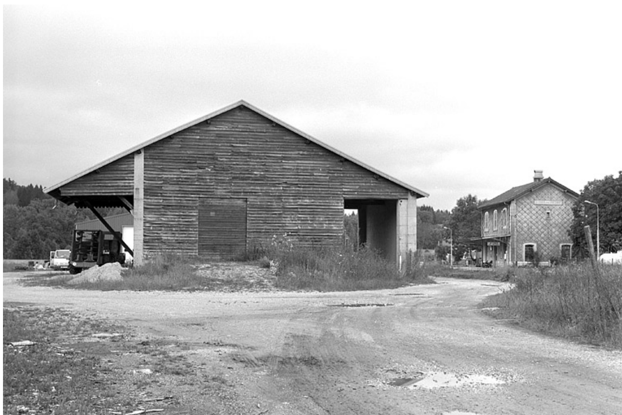
Entrepôt : façade postérieure (sud).
