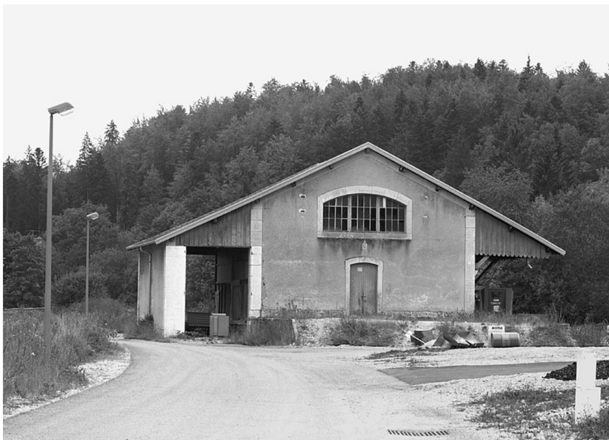
Entrepôt : façade antérieure (nord).
