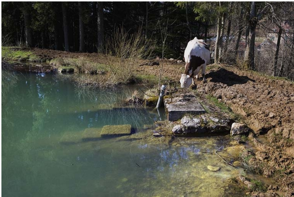
Réservoir : vannes de prise d'eau.
