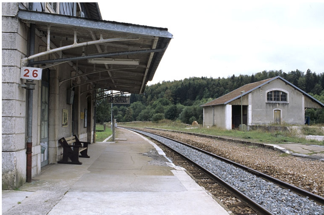
Quai des voyageurs, auvent et entrepôt commercial.
