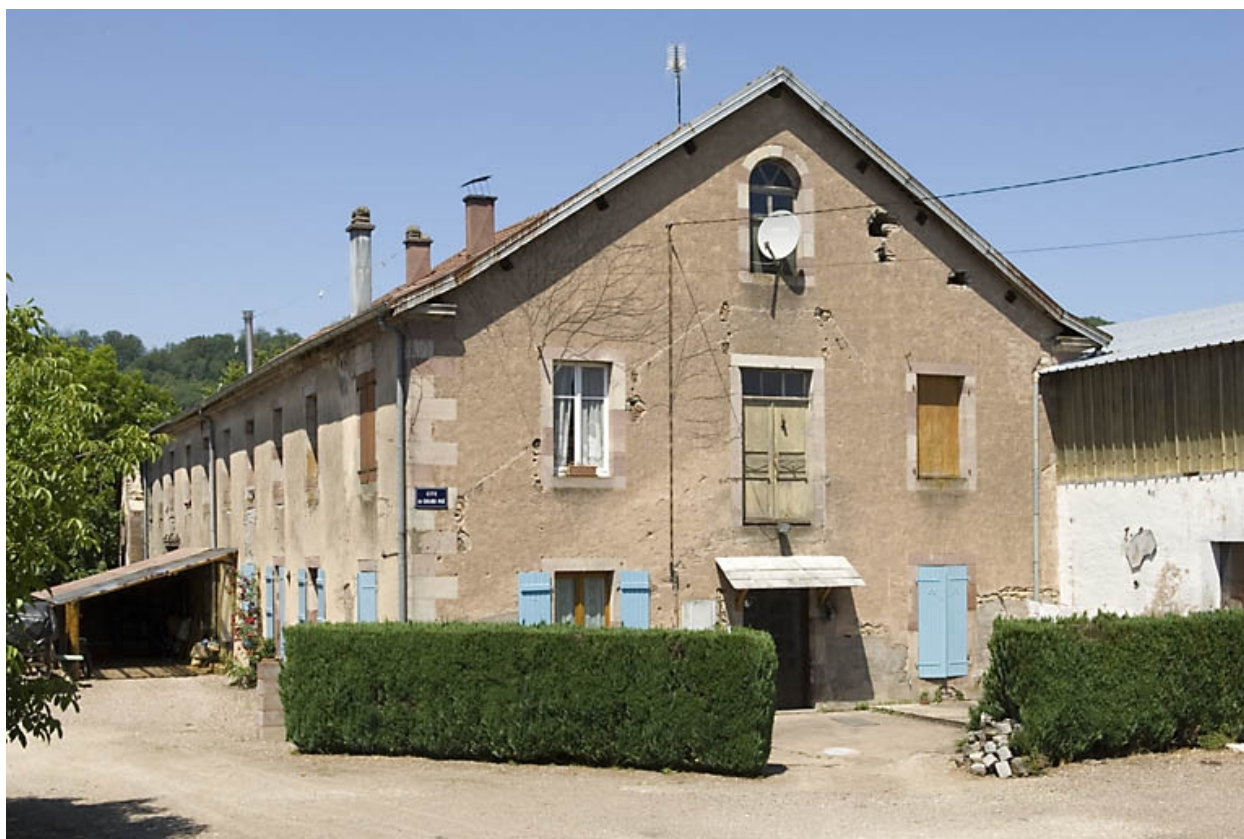
Atelier de fabrication. Vue depuis le sud-est.
