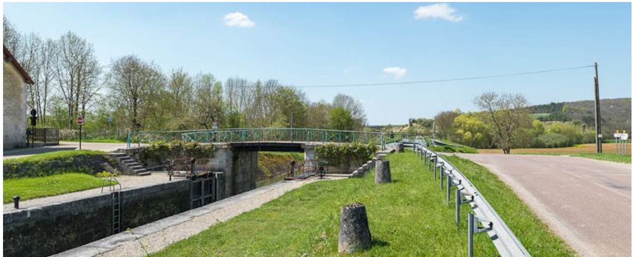
Le pont depuis le sas.
