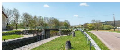
Le pont depuis le sas. Phot. Pierre-Marie Barbe-Richaud
