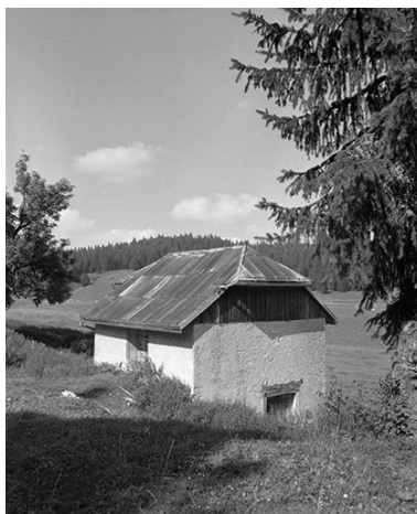
Bâtiment annexe. Phot. Yves Sancey IVR43_19782500416X
