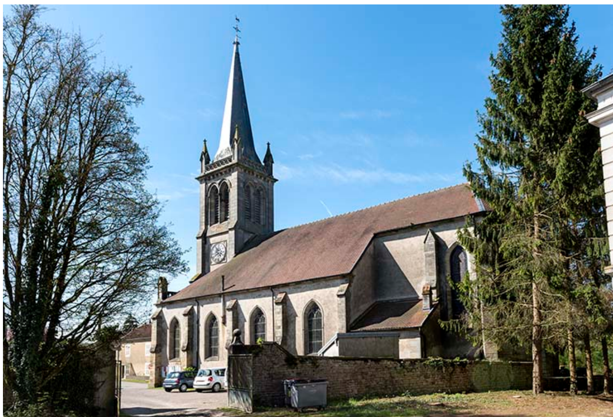
Vue d'ensemble depuis le parc du château.
