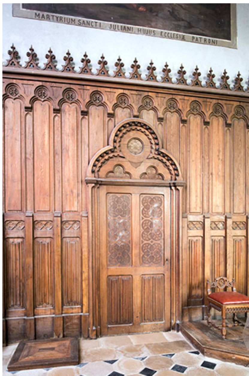
Vue des lambris de demi-revêtement du chœur.
