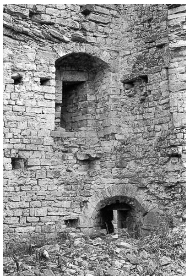
Le château-fort, vue de l'intérieur. Phot. Guy Forestier IVR43_19743900742Z
