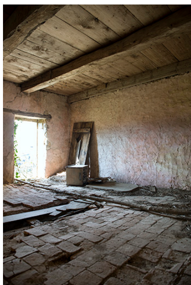
L'étage avec au sol, des tomettes. Phot. Sonia Dourlot IVR43_20167000606NUC4A
