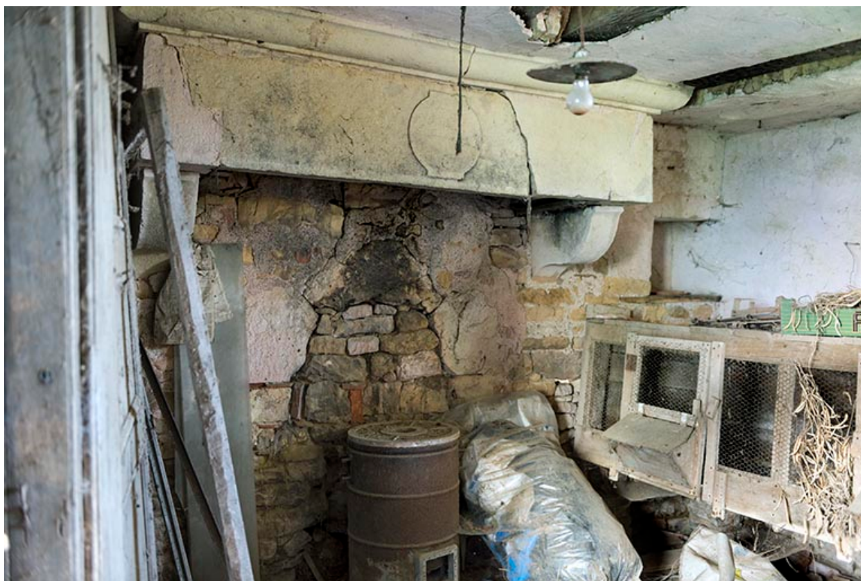
Cheminée au rez-de-chaussée du pigeonnier.
