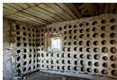
Les boulins, vue d'ensemble. Phot. Sonia Dourlot IVR43_20167000608NUC4A
