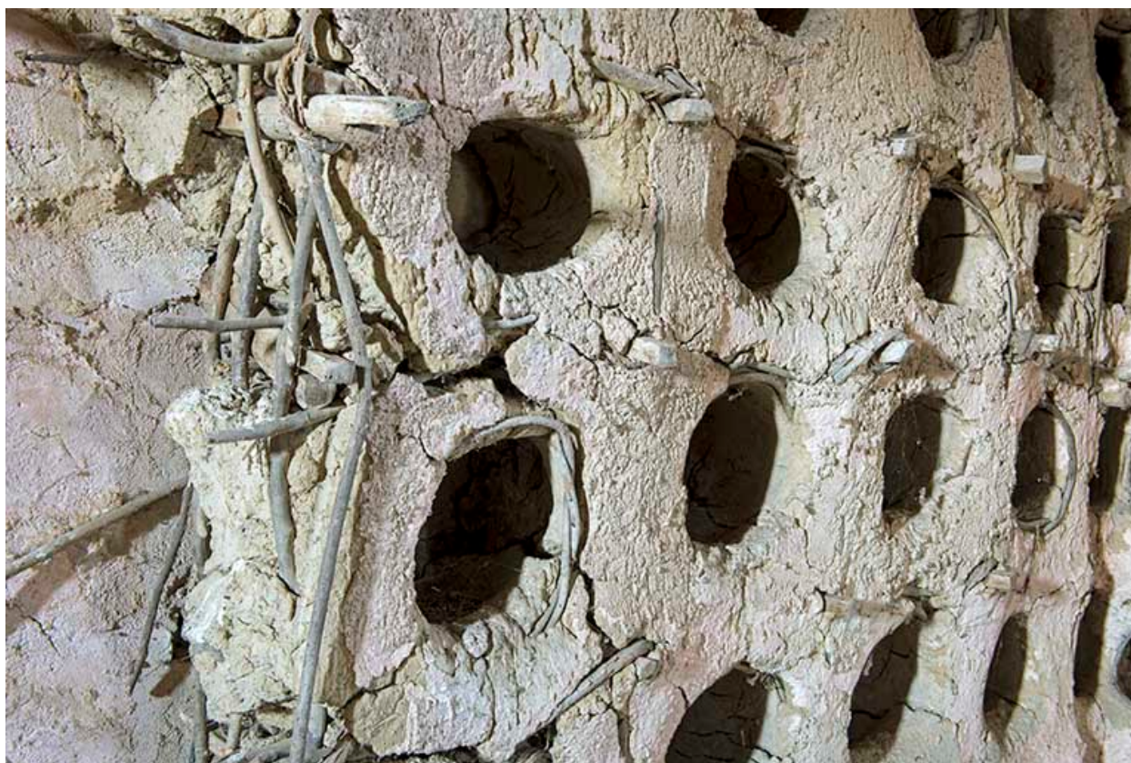
Détail sur la construction des boulins.
