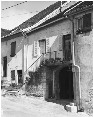
Façade antérieure. Phot. Dominique Dominguez IVR43_19803900177X
