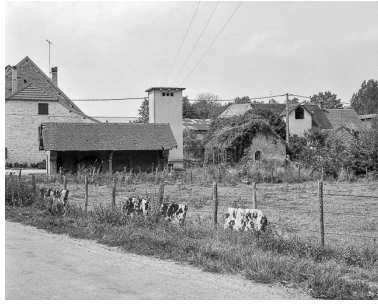
Face postérieure. Phot. Yves Sancey IVR43_19843900325X
