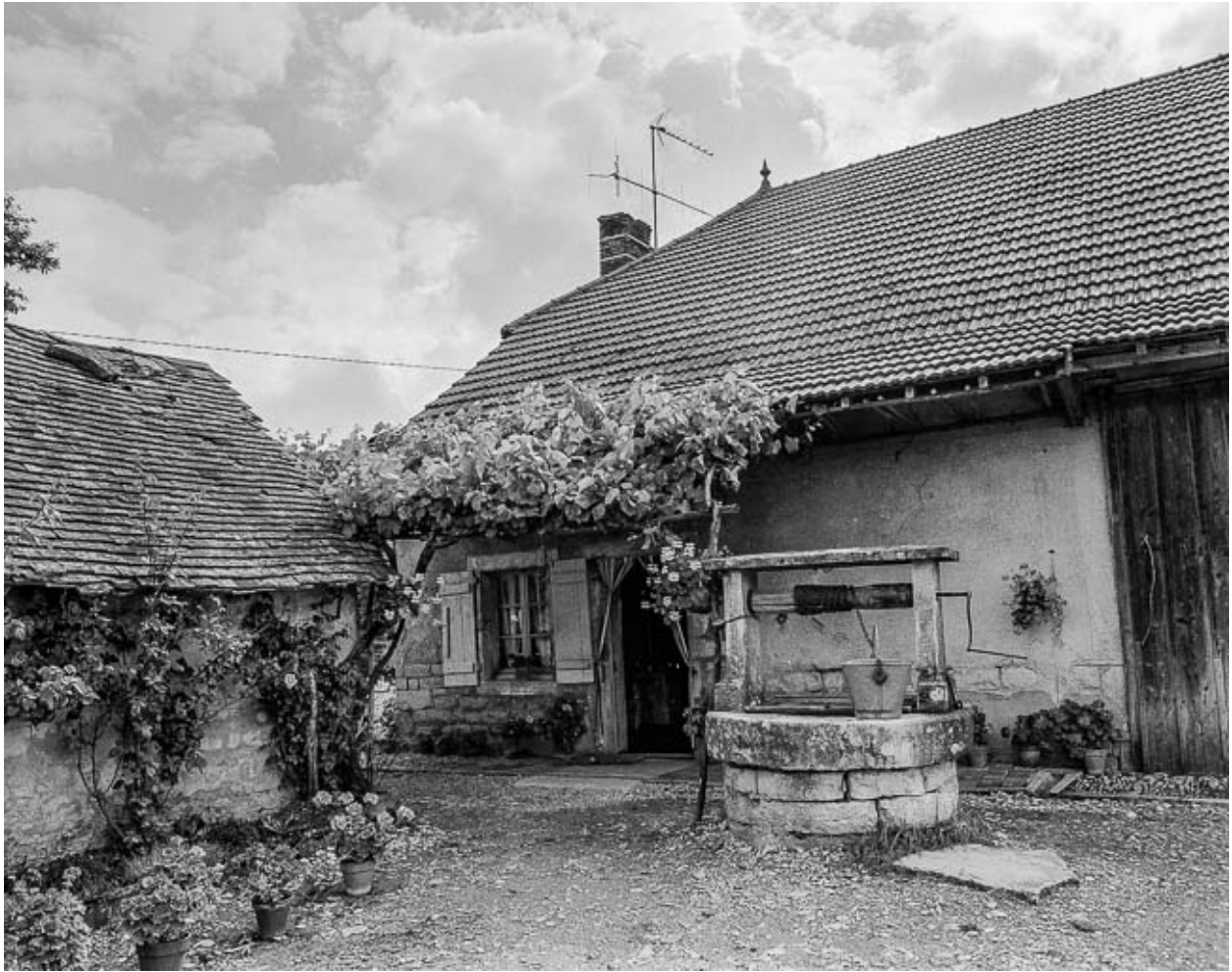
Façade antérieure de l'habitation.
