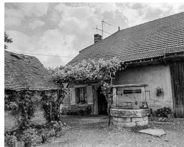
Façade antérieure de l'habitation. Phot. Dominique Dominguez IVR43_19773900059X
