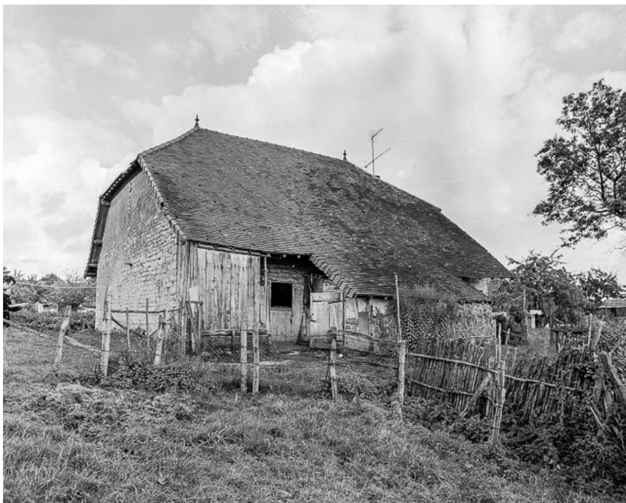
Façade postérieure et face droite.
