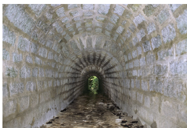
Voûte appareillée en rouleaux à ressauts, depuis l'amont. Phot. Yves Sancey IVR43_20050100014ZA
