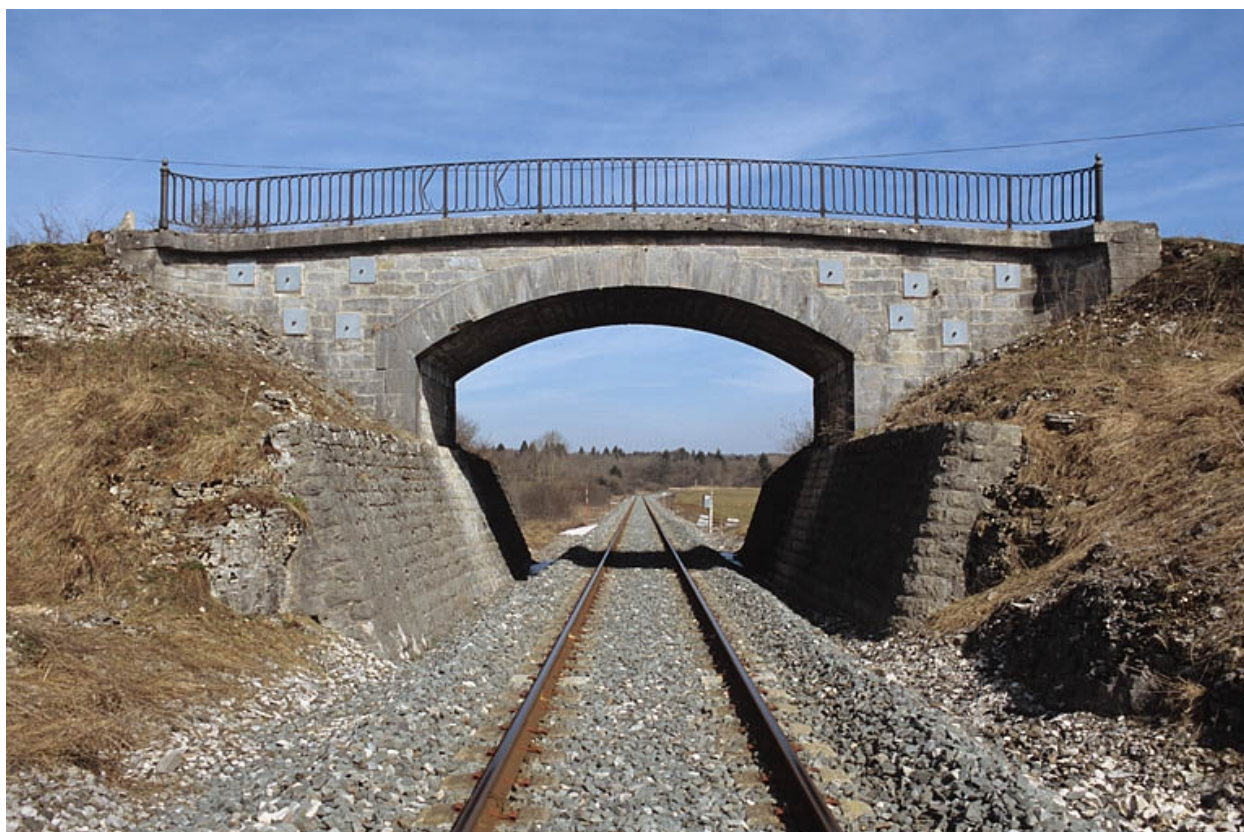
Pont routier (Le Pasquier, les Champs au Roi) : vue d'ensemble, depuis le nord (côté Andelot-en-Montagne).
