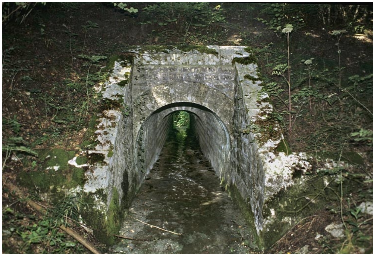
Tête amont (avec éclairage au flash).
