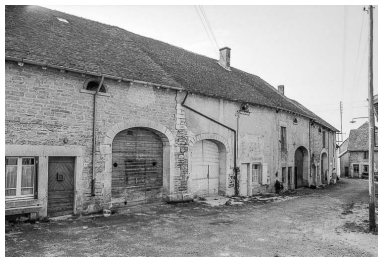
Façades sur rue. Phot. Bernard Pontefract IVR43_19763900357Z
