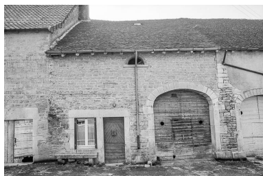
Façade antérieure. Phot. Bernard Pontefract IVR43_19763900356Z
