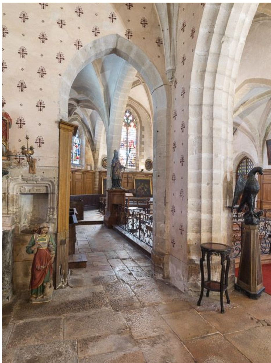
Choeur : vue depuis la chapelle nord.
