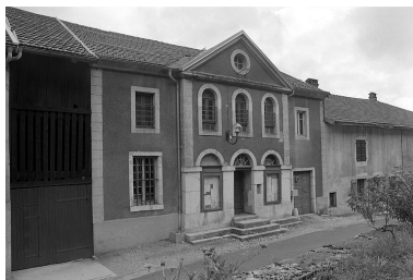
Façade antérieure. Phot. Jérôme Mongreville IVR43_19963901598X
