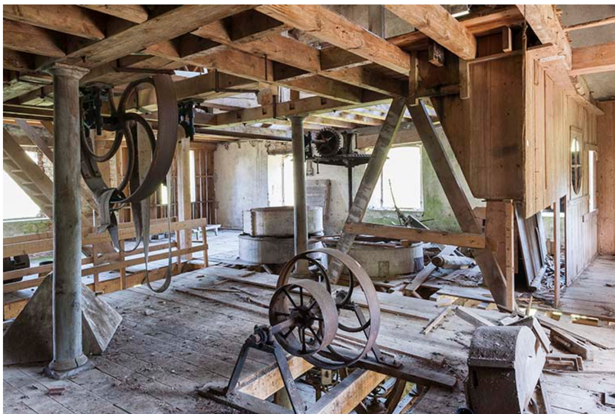
Premier étage. Vue d'ensemble depuis le sud-est.
