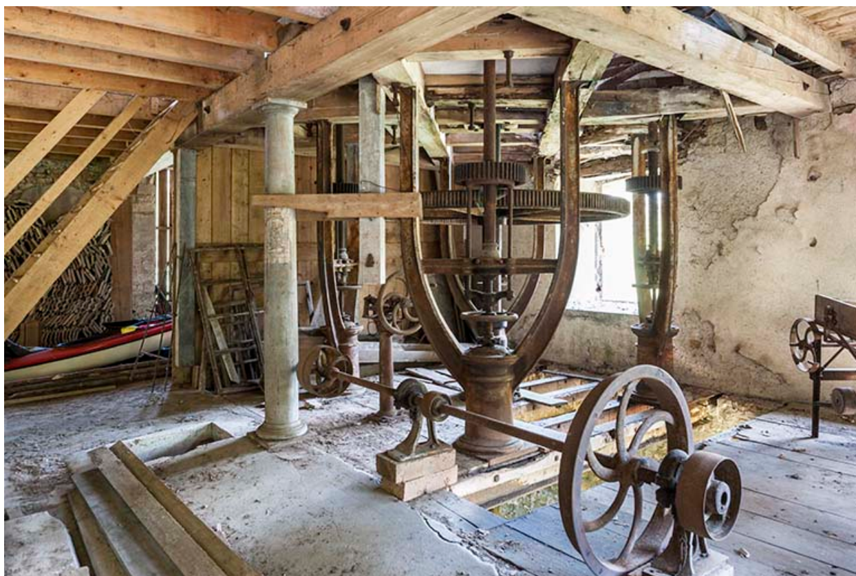
Rez-de-chaussée. Le beffroi du moulin.
