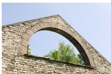
Atelier du laminoir. Baie du pignon ouest. Phot. Jérôme Mongreville IVR43_20097000353NUC2A
