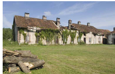
Logement ouvrier depuis la cour. Phot. Jérôme Mongreville IVR43_20097000362NUC2A
