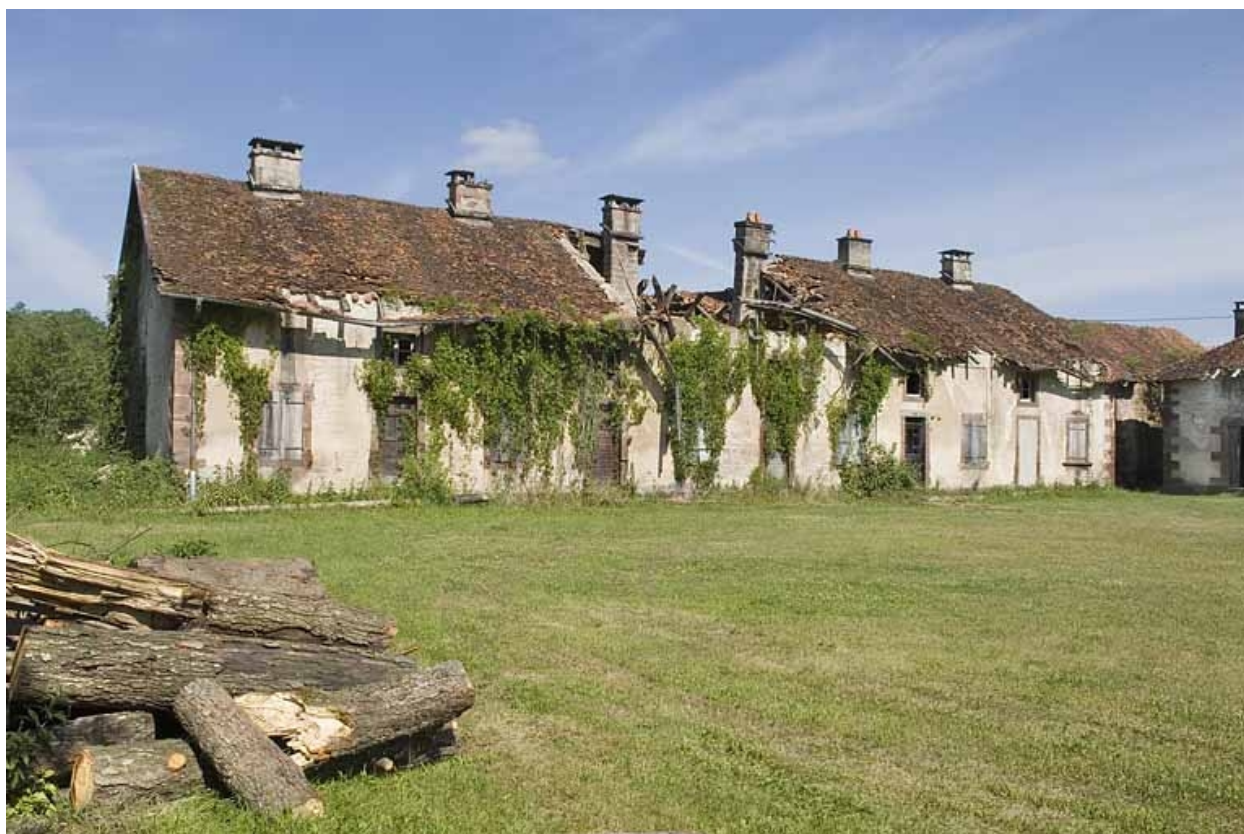
Logement ouvrier depuis la cour.
