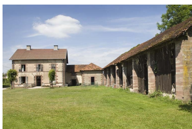
Pavillon est et halle à charbon. Phot. Jérôme Mongreville IVR43_20097000350NUC2A
