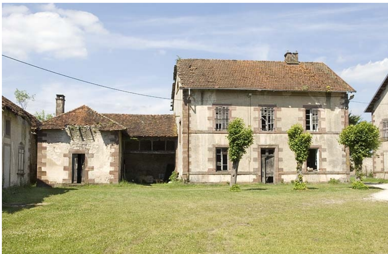
Pavillon ouest depuis la cour.
