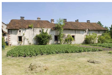
Façade postérieure du logement ouvrier. Phot. Jérôme Mongreville IVR43_20097000354NUC2A
