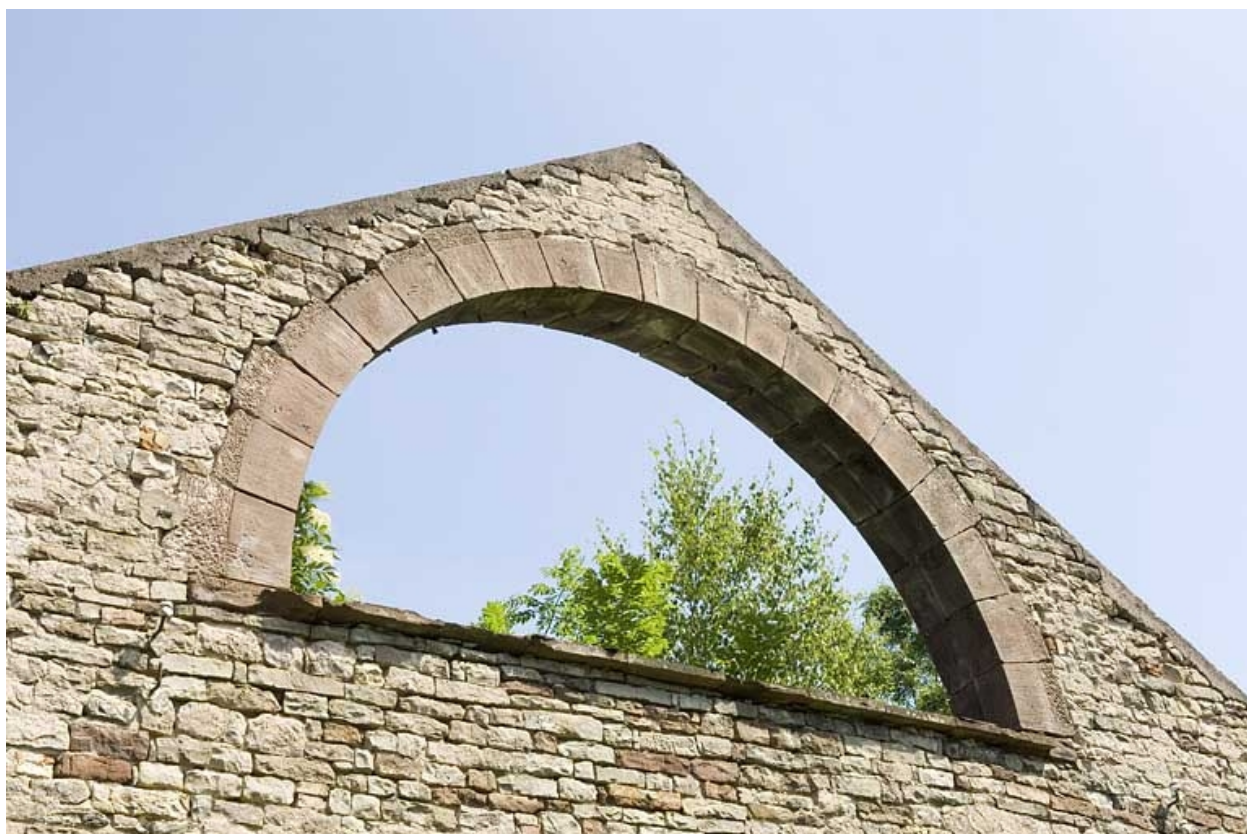
Atelier du laminoir. Baie du pignon ouest.
