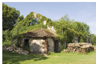
Atelier du laminoir (en ruines) depuis l'est. Phot. Jérôme Mongreville IVR43_20097000360NUC2A
