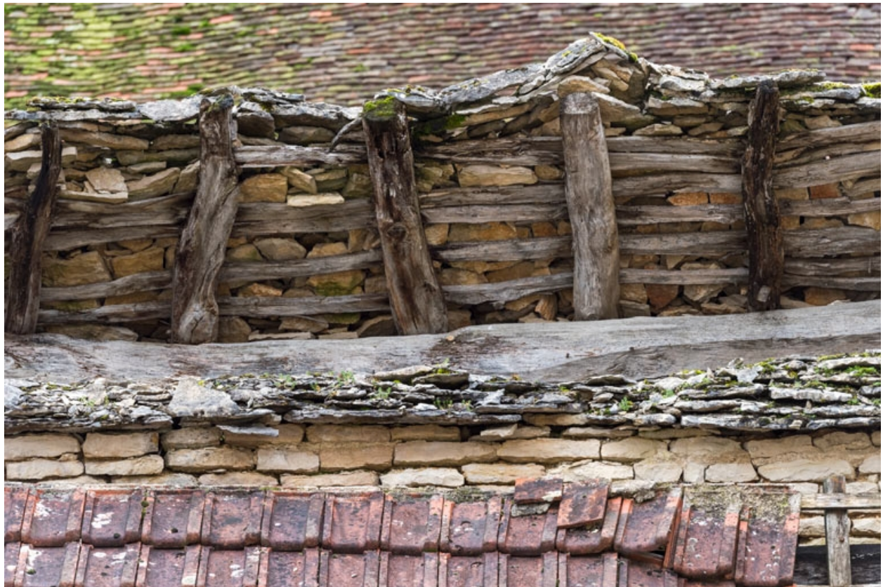
Détail de la toiture côté est.
