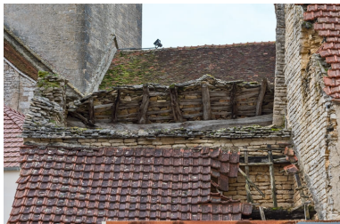
Détail de la toiture côté est. Phot. Pierre-Marie Barbe-Richaud IVR26_20222101126NUC4A
