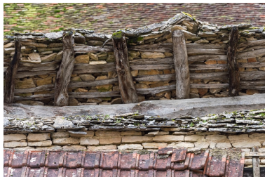
Détail de la toiture côté est. Phot. Pierre-Marie Barbe-Richaud IVR26_20222101125NUC4A
