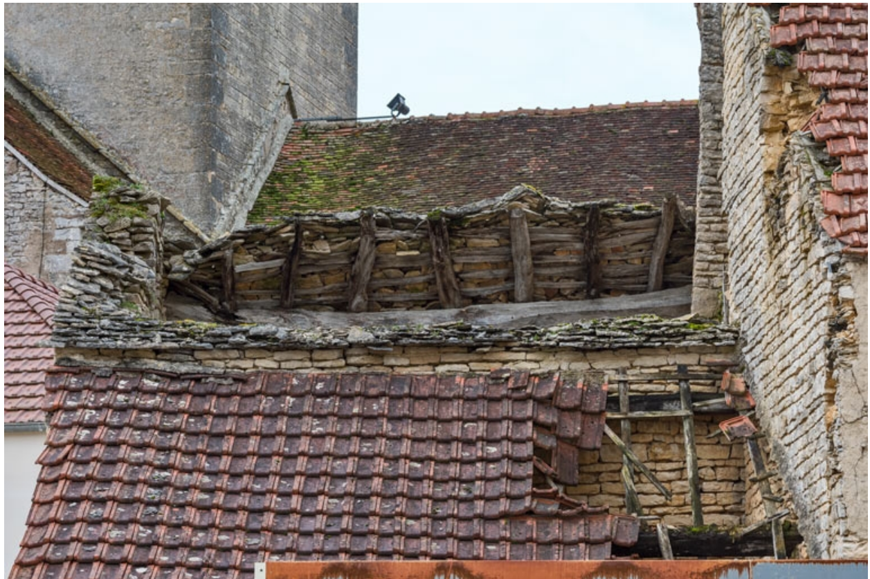
Détail de la toiture côté est.
