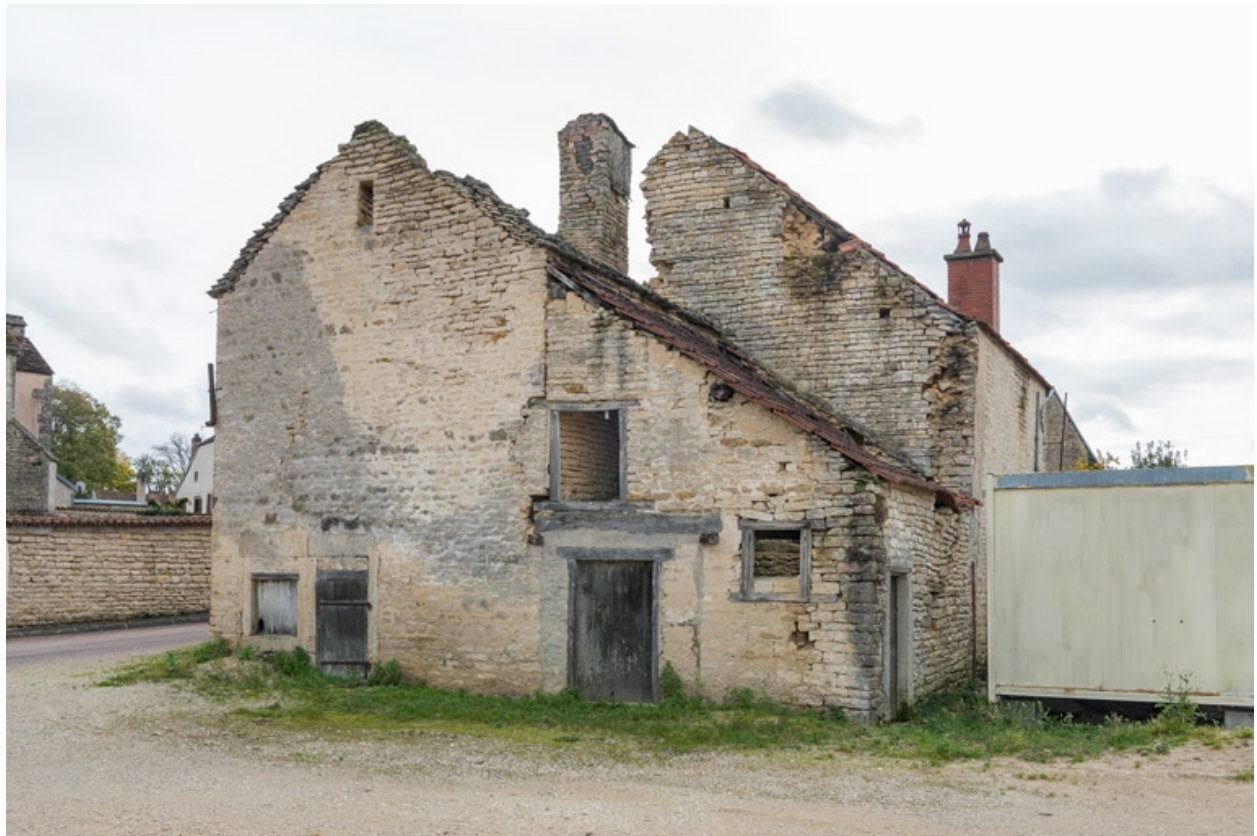
Vue du mur pignon sud.
