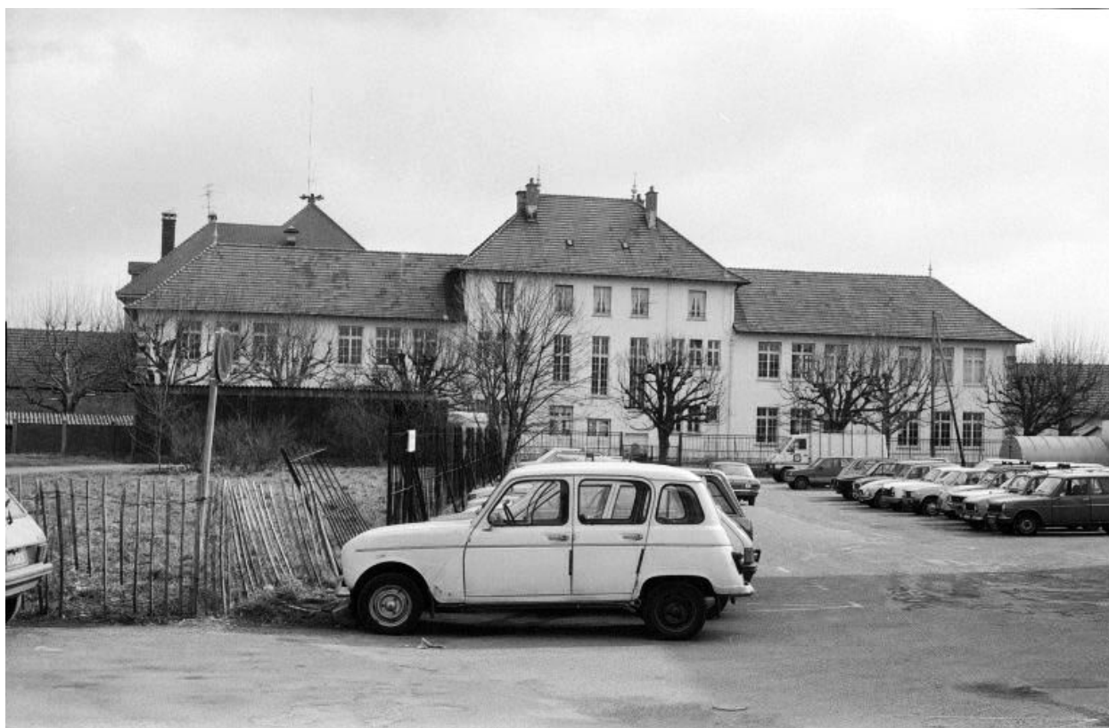
Façade postérieure sur cour.
