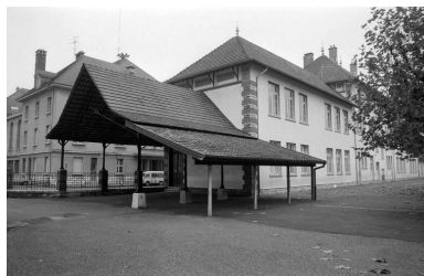
Façade sur cour, de trois quarts gauche. Phot. Bernard Lardière IVR43_19832500147Z
