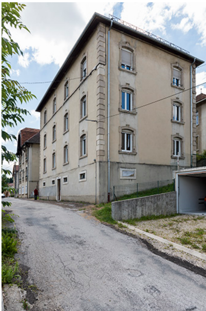
Façades antérieure et latérale droite.
