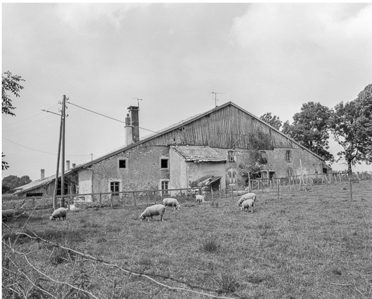
Pignon d'habitation et goutterot.
