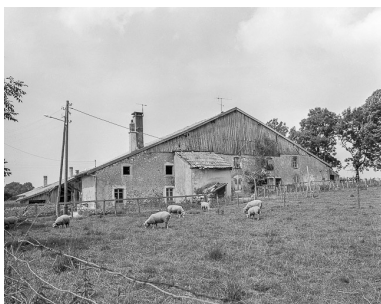
Pignon d'habitation et goutterot.
