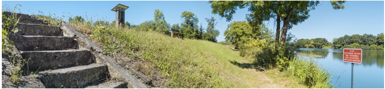
Escaliers du barrage. A droite, la Saône.
