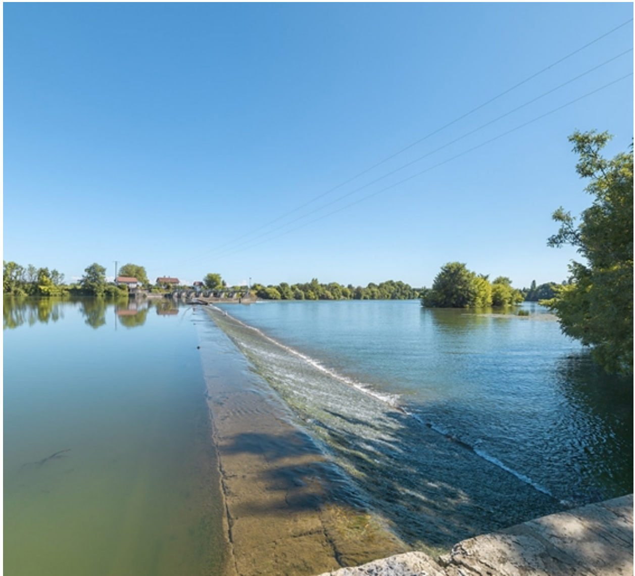
Le déversoir du barrage.
