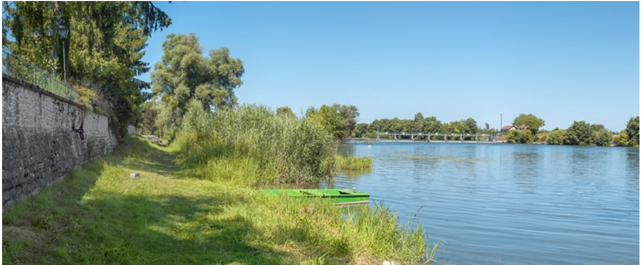
Vue d'ensemble d'aval.
