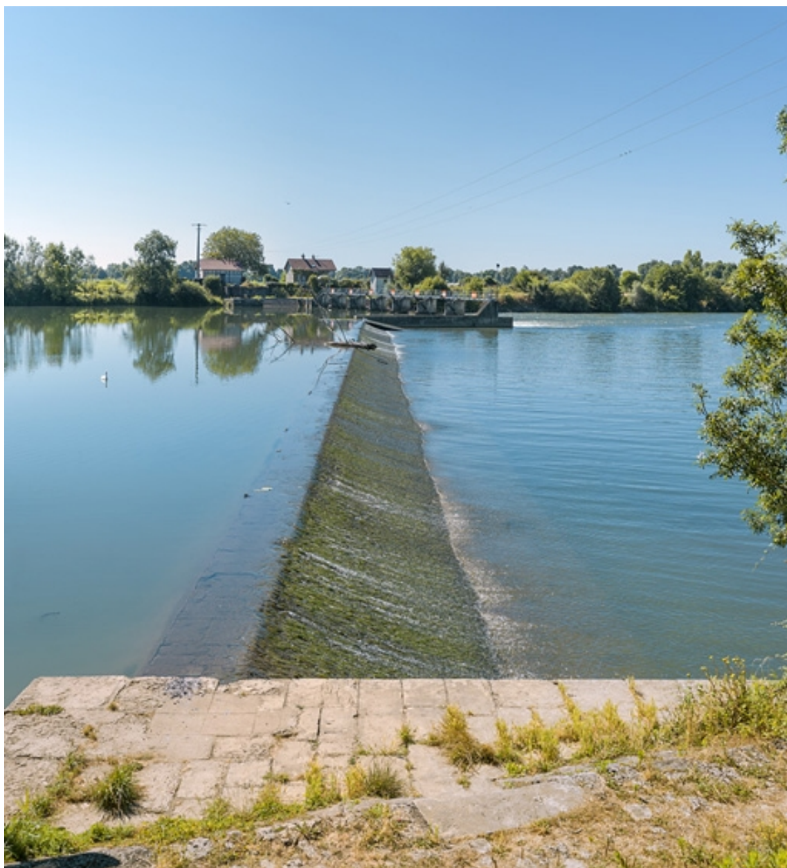
Le déversoir du barrage.
