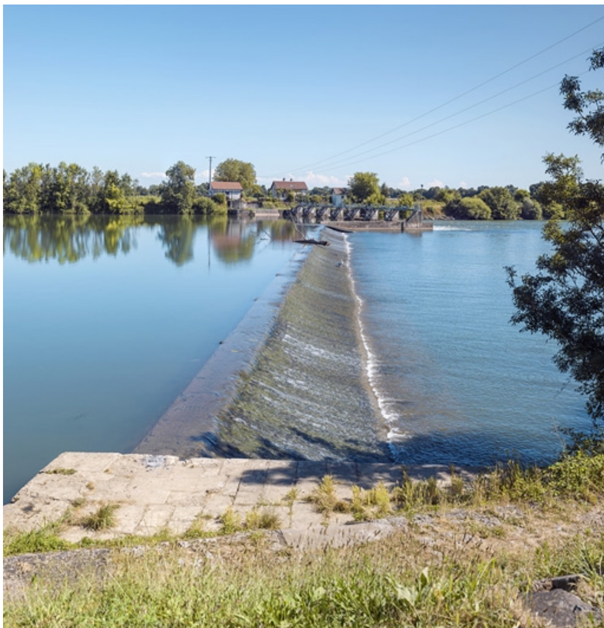
Le déversoir du barrage.
