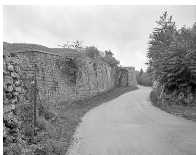
Vue du front de gorge. Phot. Yves Sancey IVR43_19802500568X
