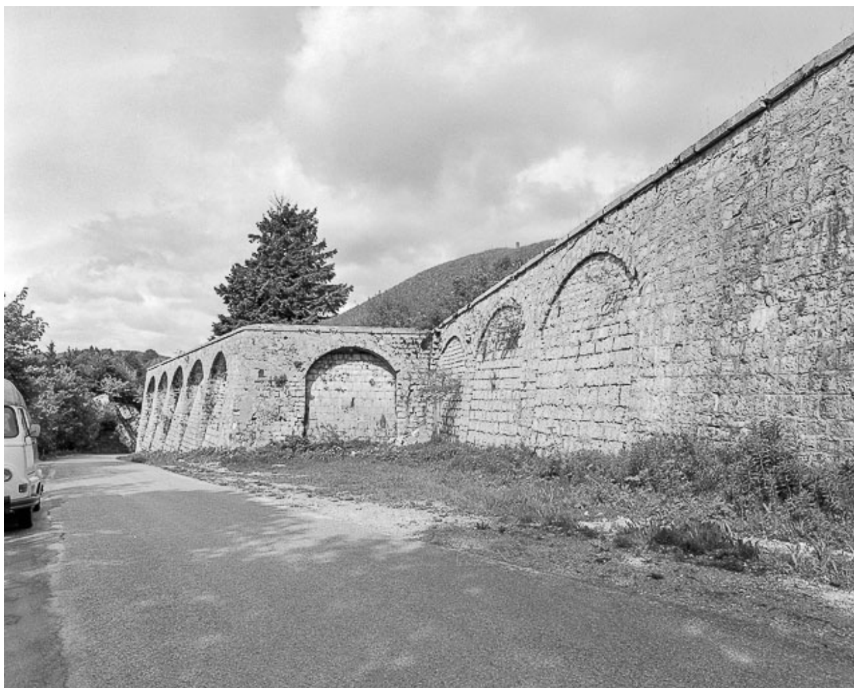
Créneaux de pied défendant l'enceinte : vue éloignée.
