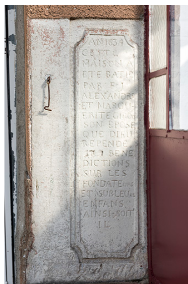
Pierre de fondation, 1 rue des Vergers. Phot. Sonia Dourlot IVR43_20177000085NUC4A
