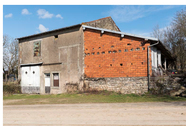
Maison rue des Canes. Phot. Sonia Dourlot IVR43_20177000077NUC4A
