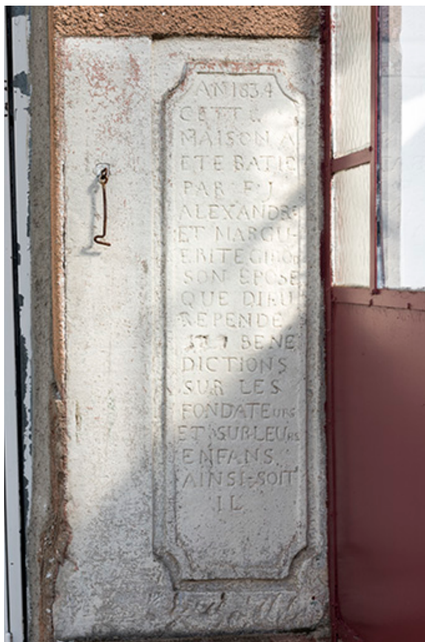
Pierre de fondation, 1 rue des Vergers.
