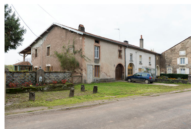
Alignement de fermes, Grande rue. Phot. Sonia Dourlot IVR43_20157001048NUC4A
