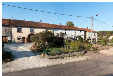
Alignement de fermes, Grande rue. Phot. Sonia Dourlot IVR43_20157001059NUC4A
