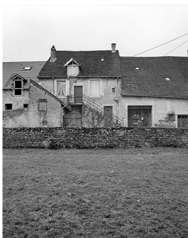
Maison située 54 rue Edmond-Chapuis. Phot. Jérôme Mongreville IVR43_19853900142X
