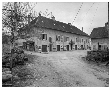
Maison située 32-36 rue Edmond-Chapuis. Phot. Jérôme Mongreville IVR43_19853900141X
