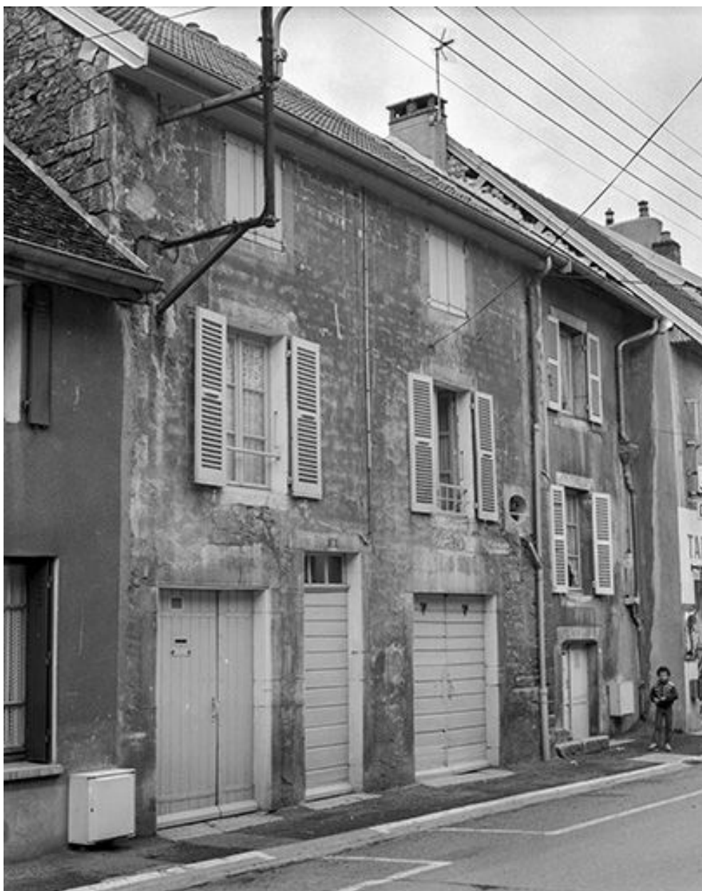
Maison située rue Jean Jaurès.
