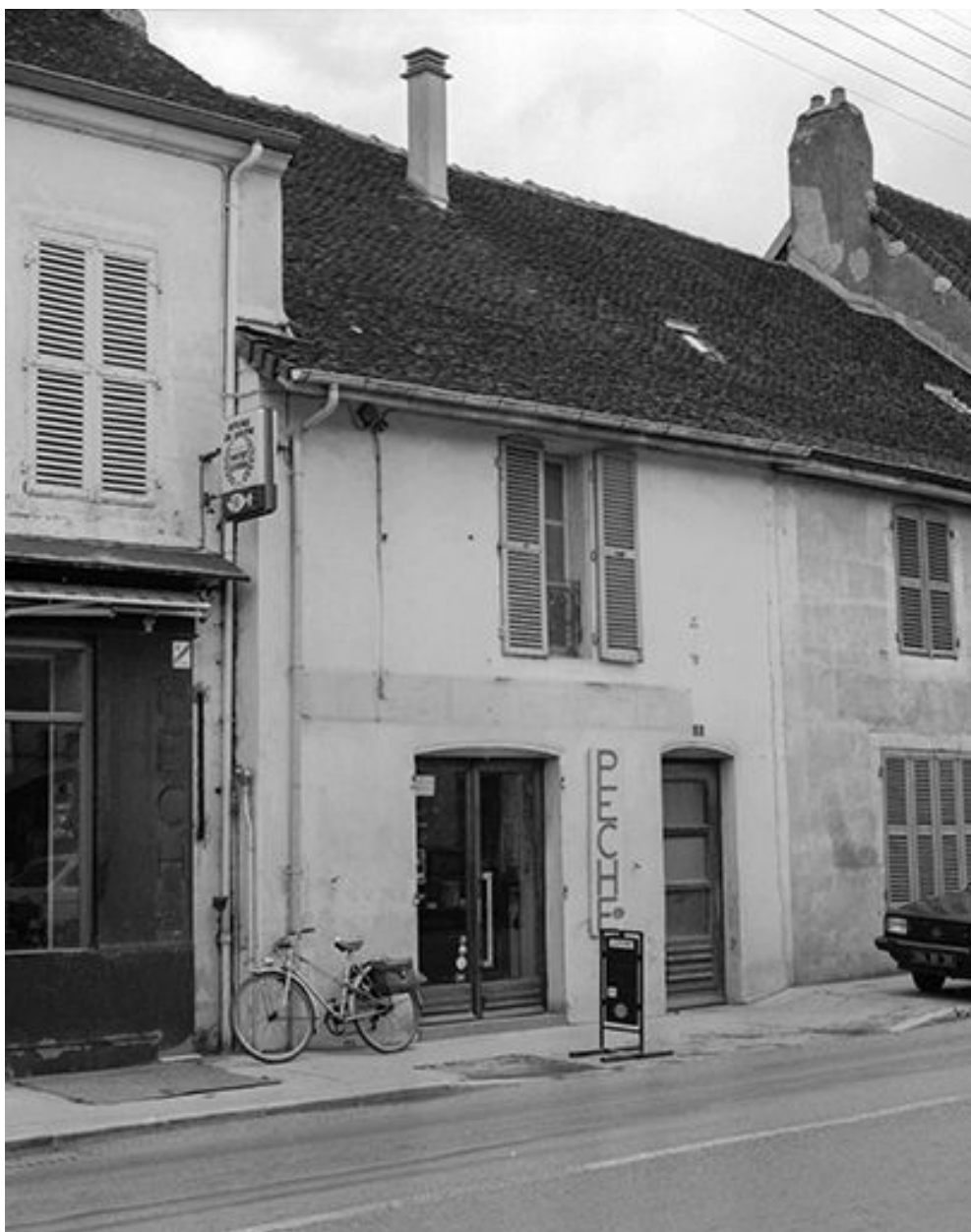
Maison située rue Aristide Briand.
