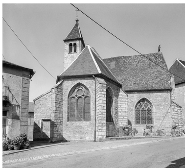
Façade postérieure. Phot. Bernard Lardière IVR43_19767000795V
