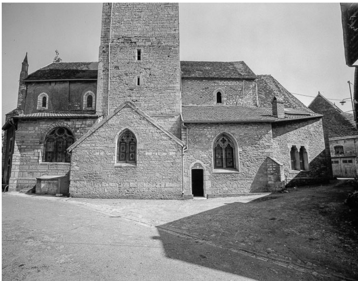
Façade latérale droite.
