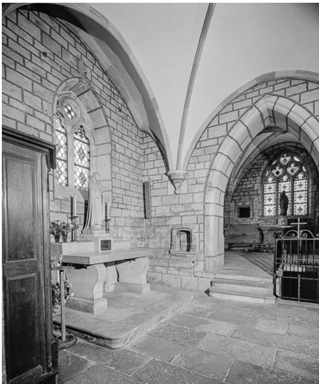
Bas côté gauche (avant la chapelle gauche).
