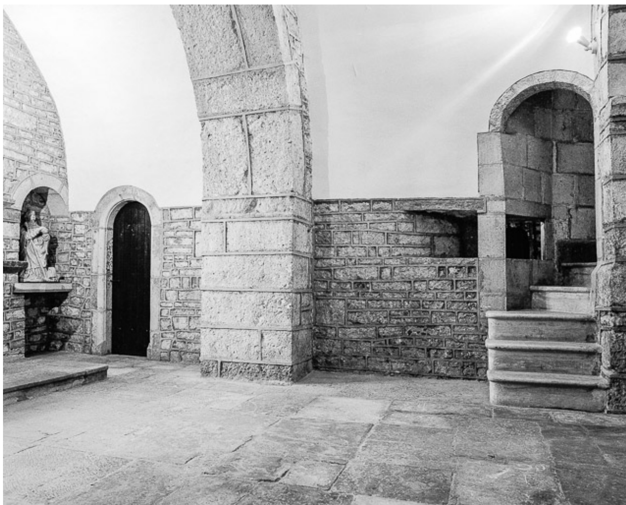
Bas côté droit, deuxième travée, mur ouest.
