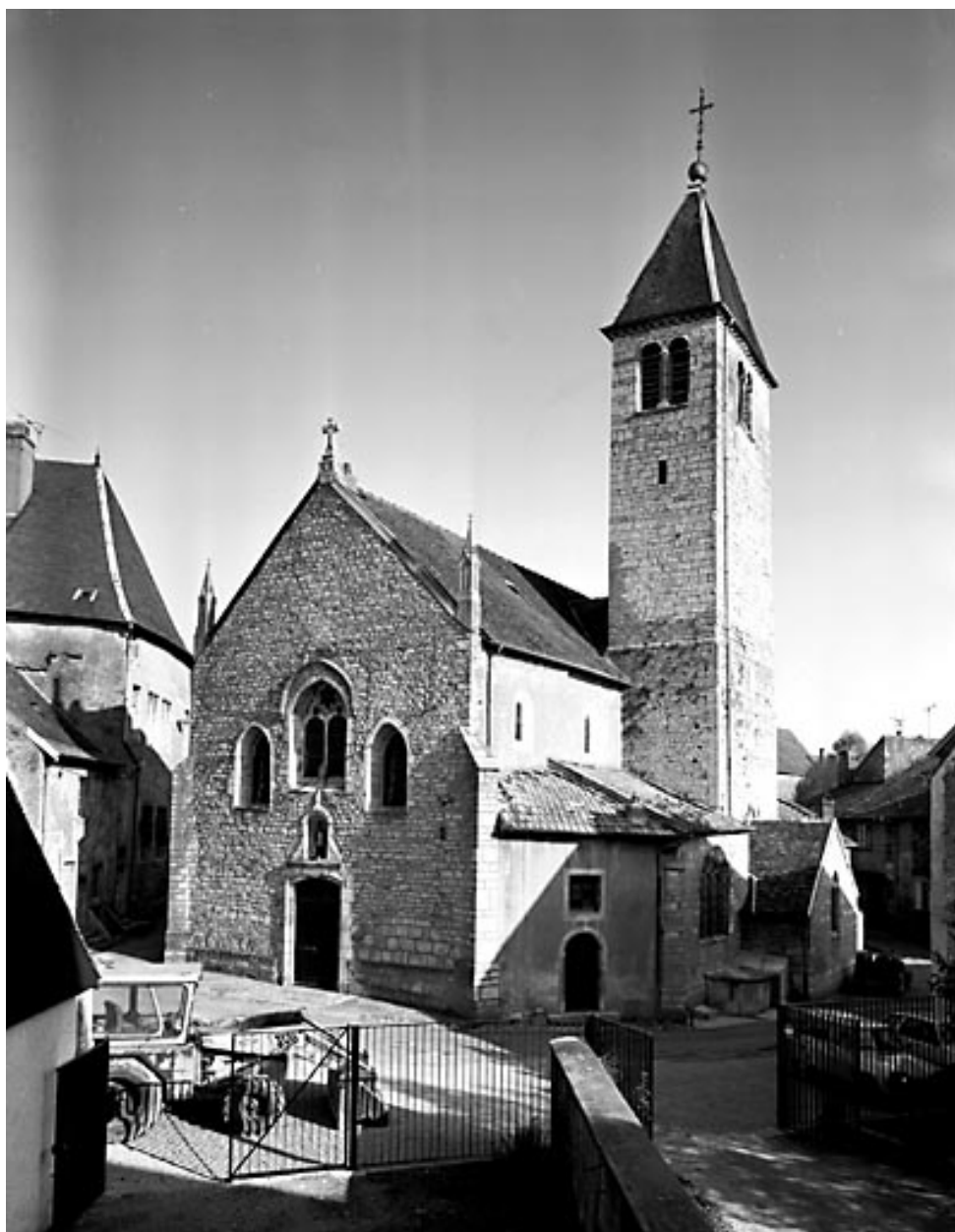
Vue des façades ouest et sud.
