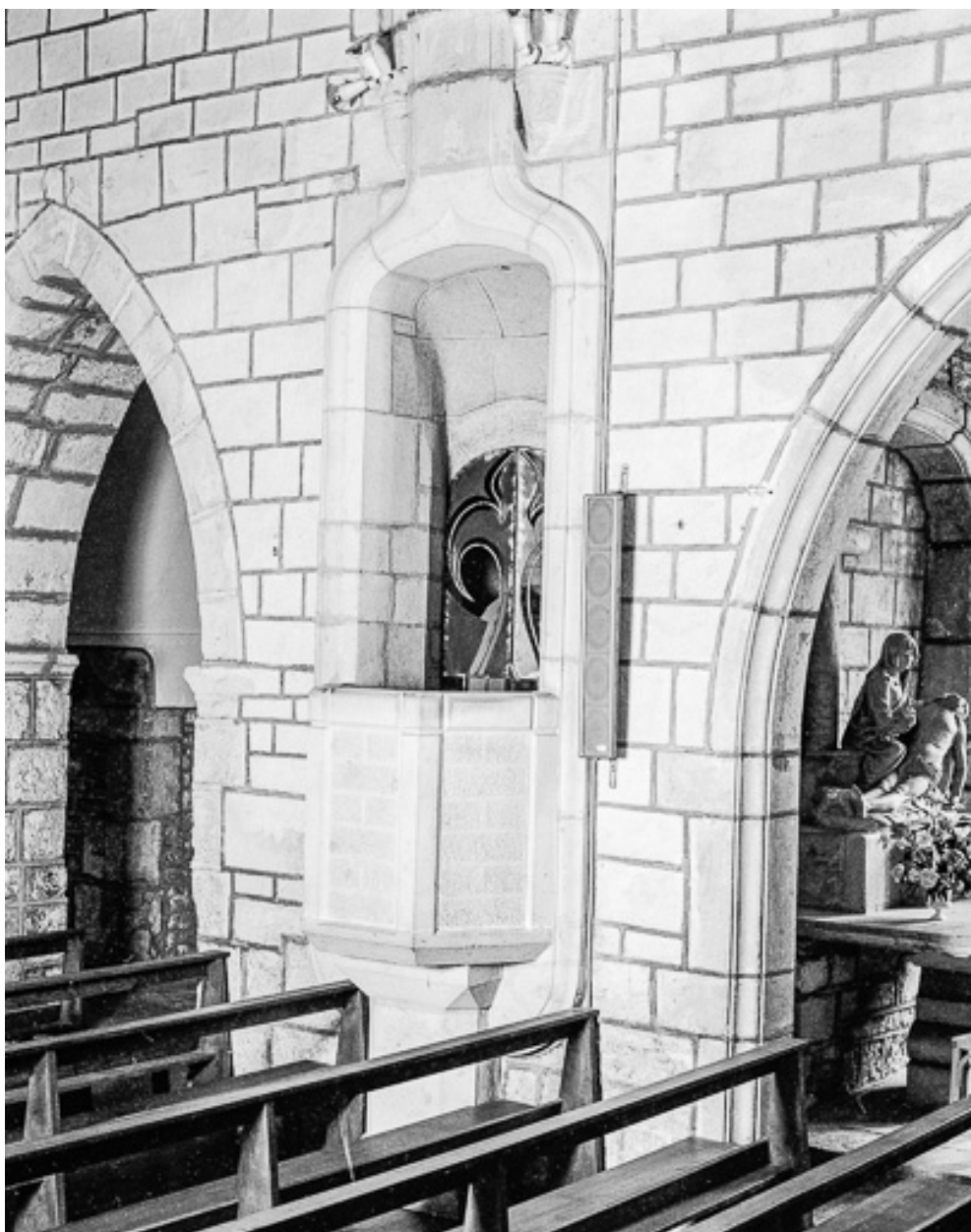
Nef : chaire à prêcher, mur droit.
