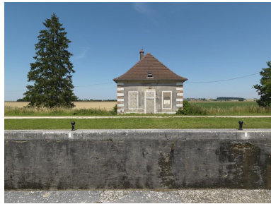
Maison éclusière : vue de face. Phot. Thierry Kuntz IVR26_20112103194NUC4A
