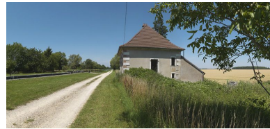
Maison éclusière vue du côté gauche. Phot. Thierry Kuntz IVR26_20112103193NUC4A
