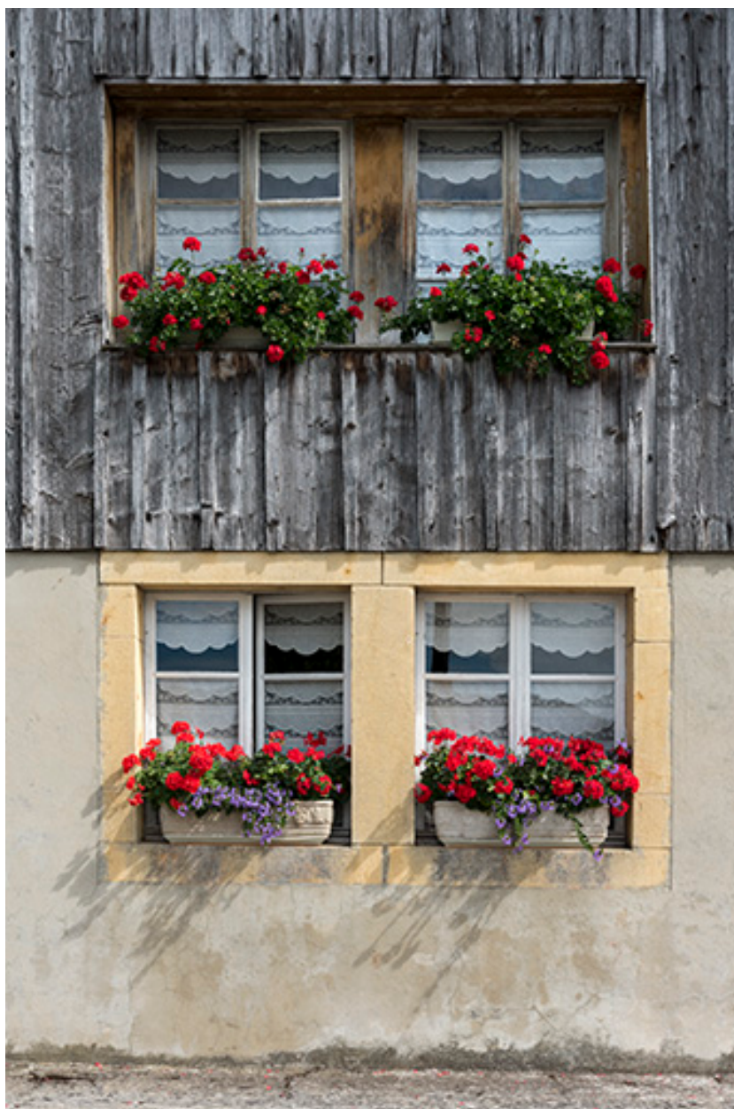
Façade antérieure : fenêtres horlogères.
