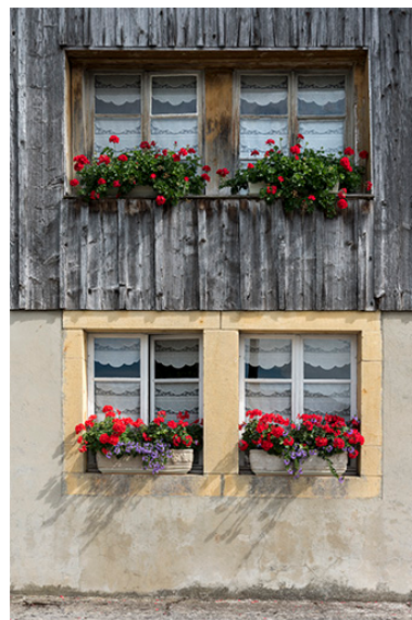
Façade antérieure : fenêtres horlogères. Phot. Sonia Dourlot IVR43_20172501039NUC4A
