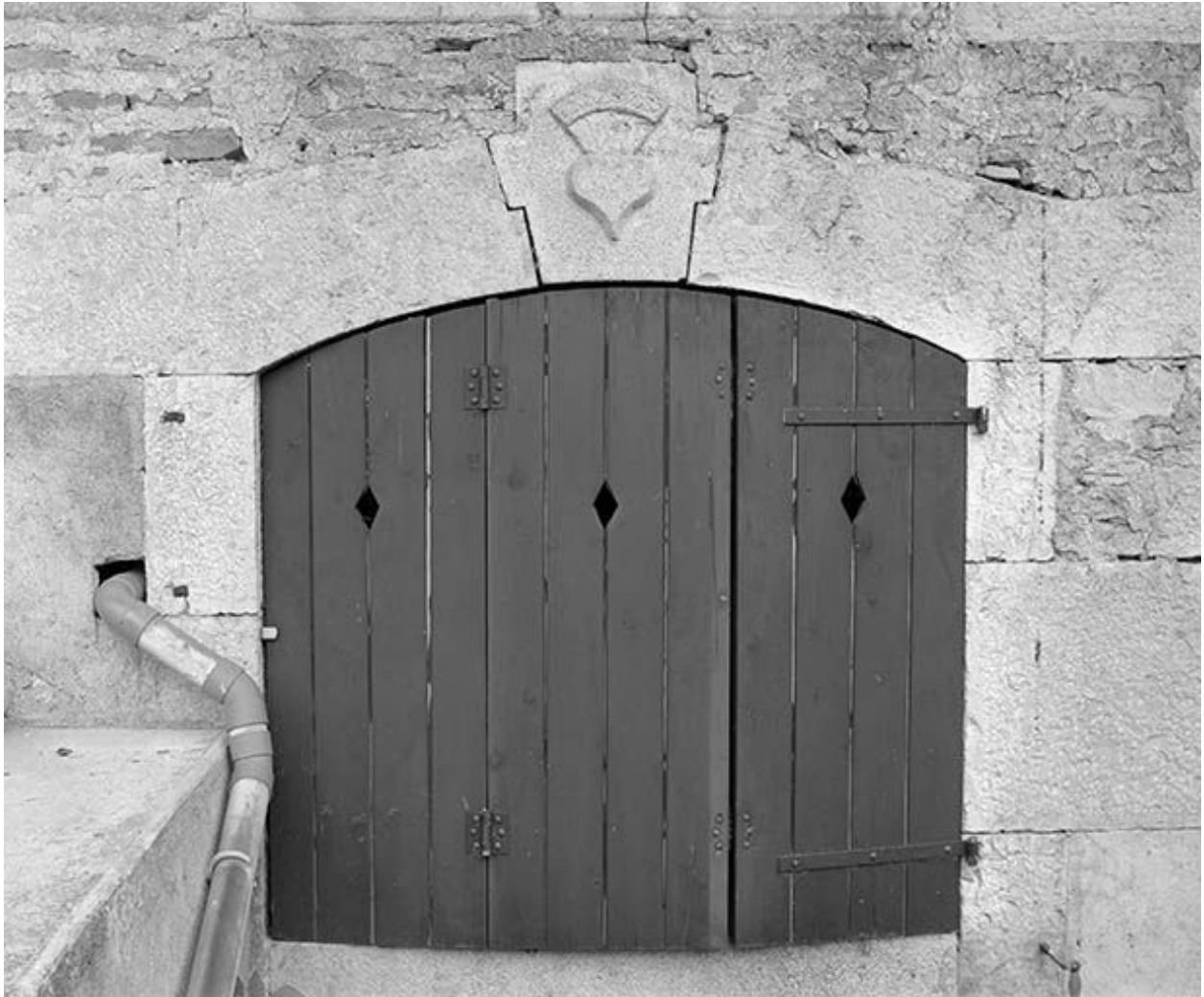
Façade antérieure : linteau de la baie éclairant le sous-sol.
