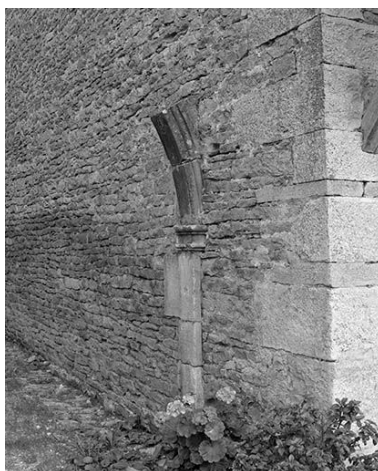
Face latérale gauche : départ d'un ancien arc. Phot. Yves Sancey IVR43_19802501139X
