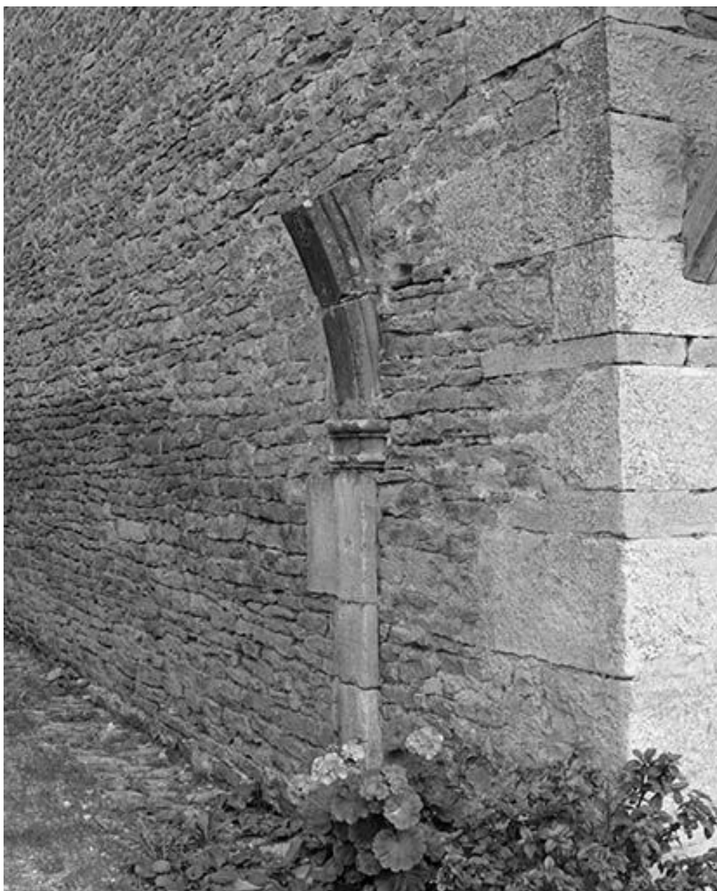
Face latérale gauche : départ d'un ancien arc.
