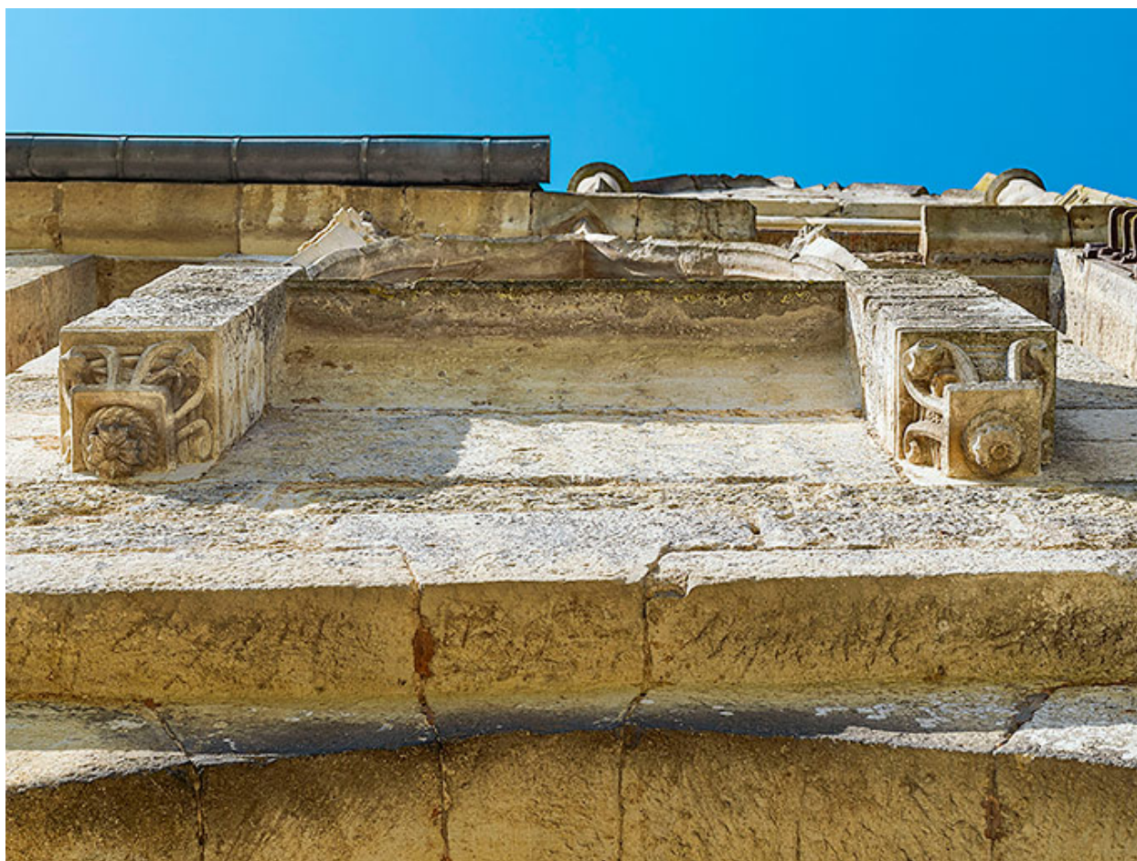
Base des piliers supportant les pinacles.
