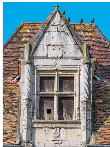
Vue de la baie à meneau. Phot. Thierry Kuntz IVR26_20232100257NUC4A
