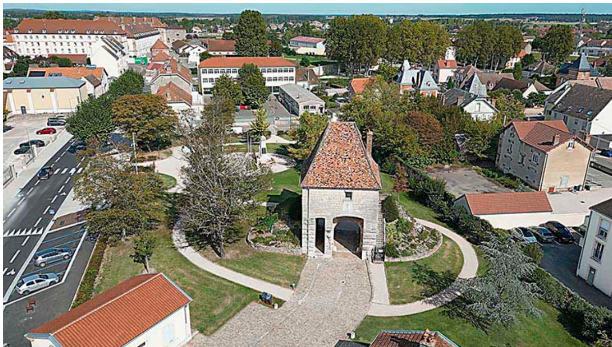
Vue aérienne de la porte.
