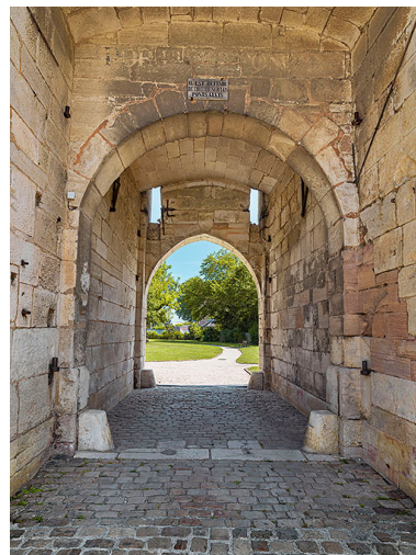
Le passage voûté. Phot. Thierry Kuntz IVR26_20232100229NUC4A
