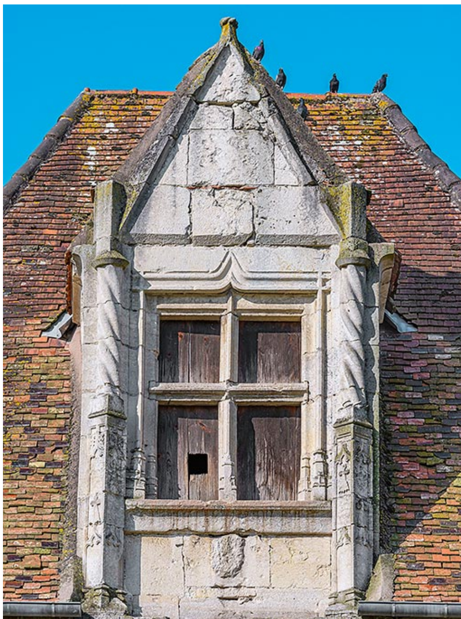
Vue de la baie à meneau.
