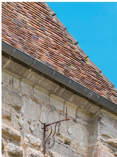
Détail de la corniche et de la couverture en tuile. Phot. Thierry Kuntz IVR26_20232100268NUC4A
