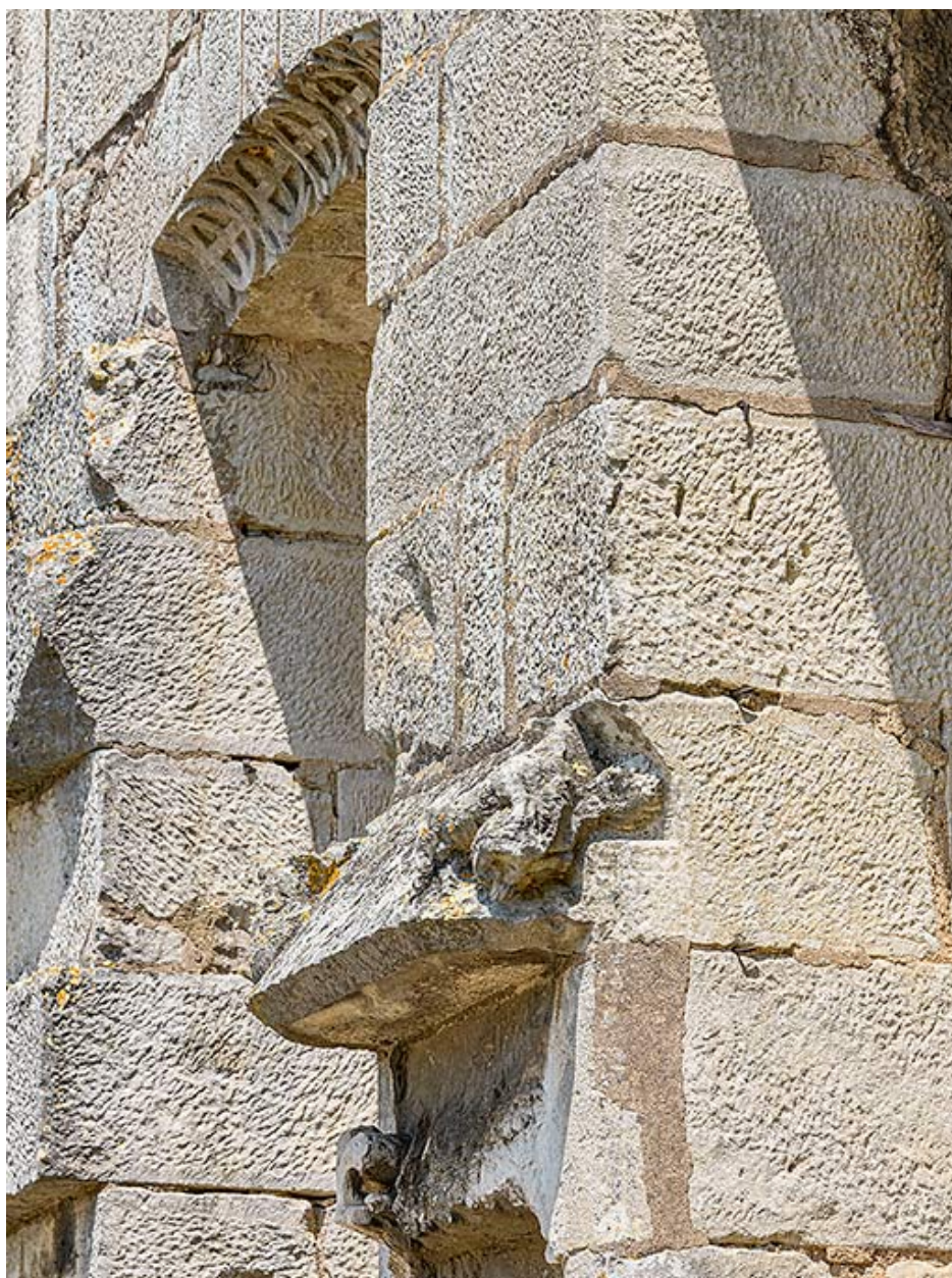
Détail sur la maçonnerie en pierre de taile.
