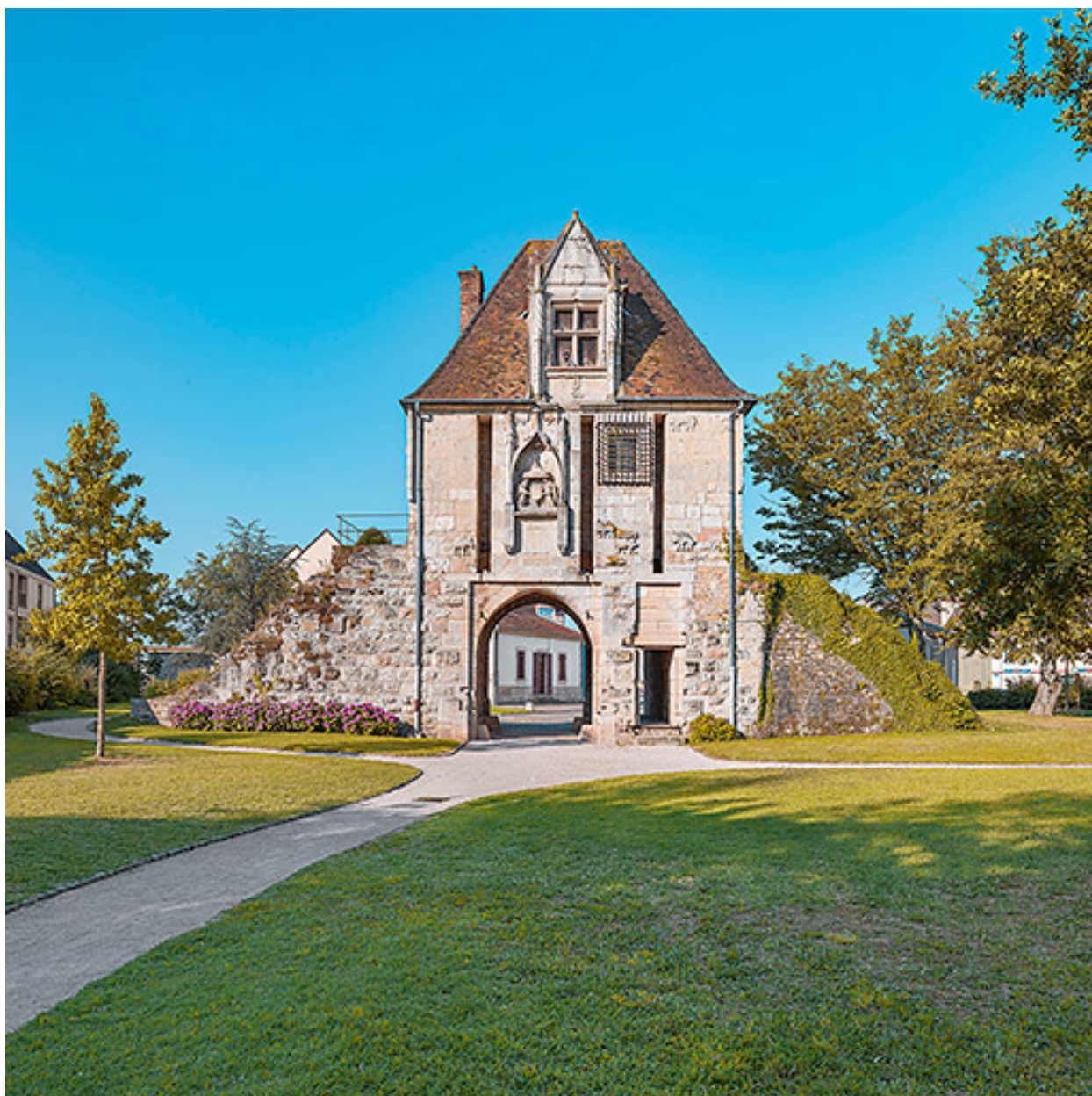
Vue générale de la façade côté campagne.
