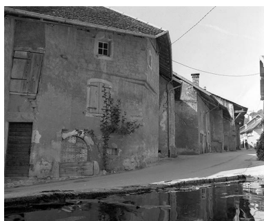
Mouthier-Haute-Pierre : élévations des maisons rue Robert Dame protégées par des auvents reposants sur des aisseliers Phot. Yves Sancey IVR43_19802501086X
