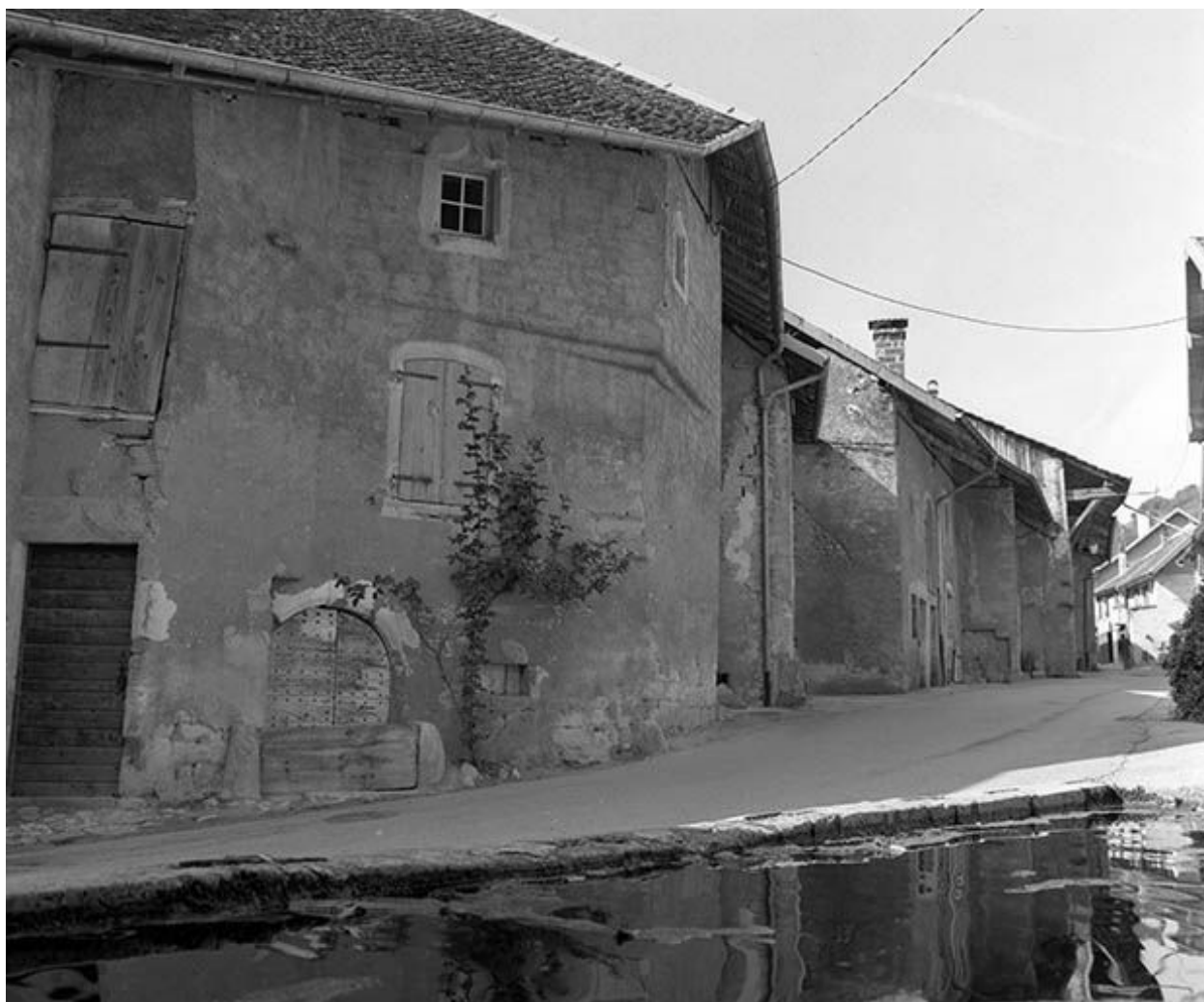
Mouthier-Haute-Pierre : élévations des maisons rue Robert Dame protégées par des auvents reposants sur des aisseliers
