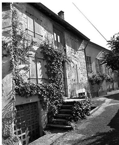
Vuillafans : maison de vigneron située 4 rue du Téméraire, à un étage carré sur cave et grenier au-dessus de la porte d'entrée.
