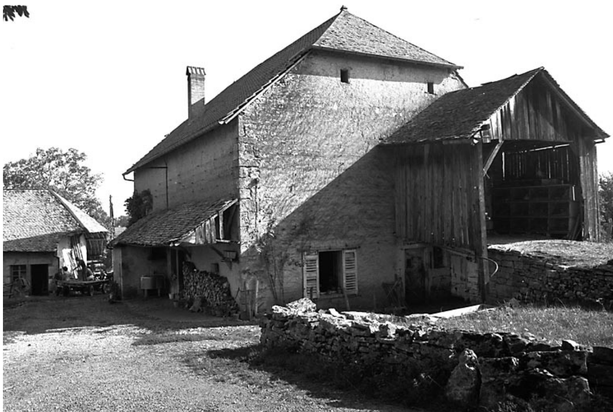
Tarcenay, les Rubis : ferme avec écurie et pont de grange sur le mur pignon.
