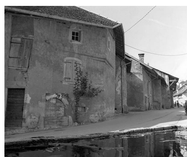
Mouthier-Haute-Pierre : élévations des maisons rue Robert Dame protégées par des auvents reposants sur des aisseliers
