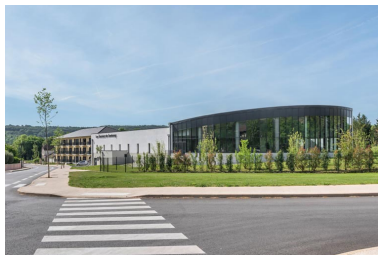
Vue depuis le nord. Phot. Pierre-Marie Barbe-Richaud IVR26_20222100208NUC4A
