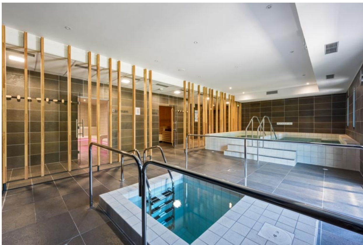
Spa thermoludique, hamman, sauna et bassins.
