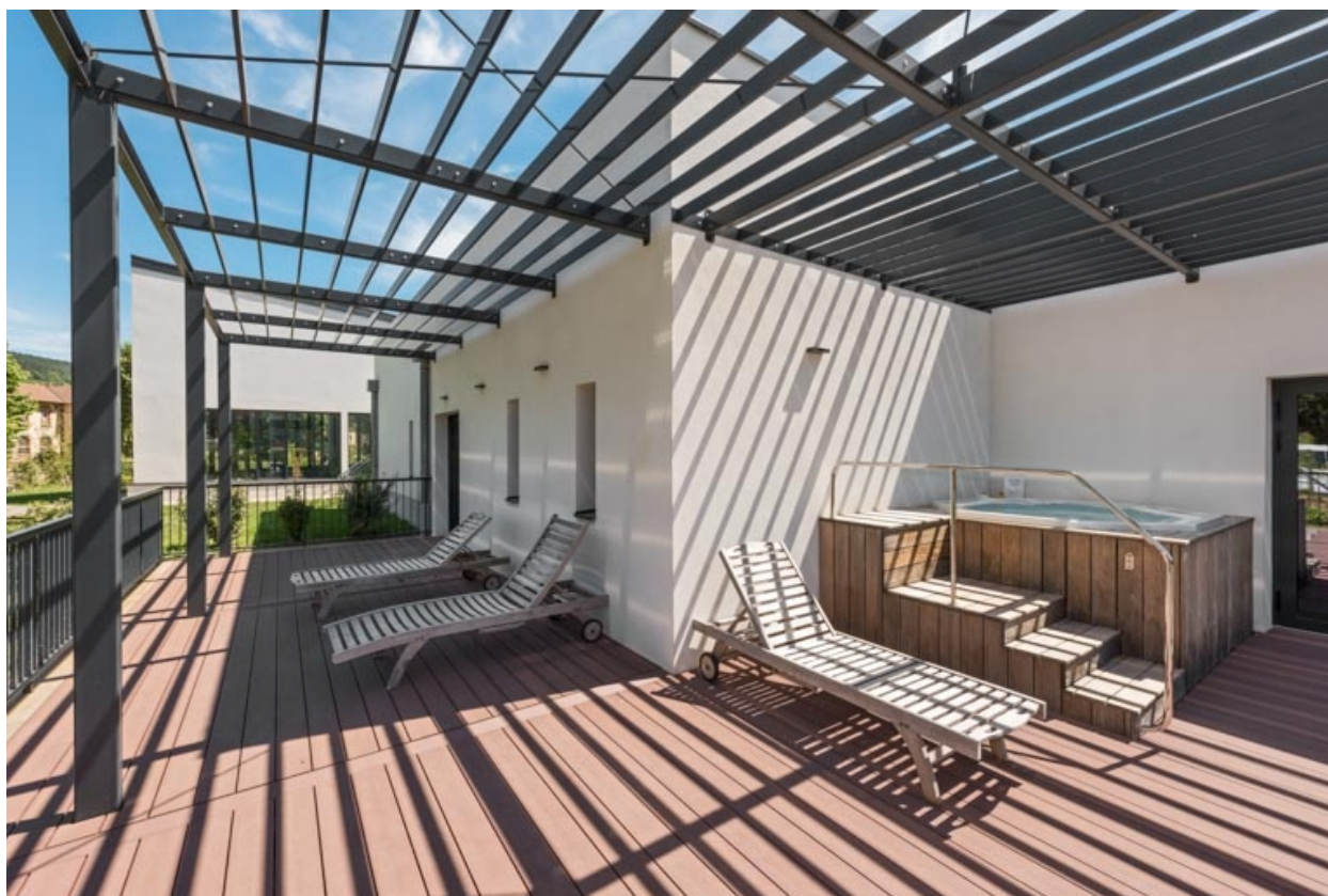
Spa thermoludique, terrasse extérieure.
