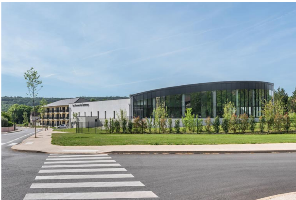
Vue depuis le nord.
