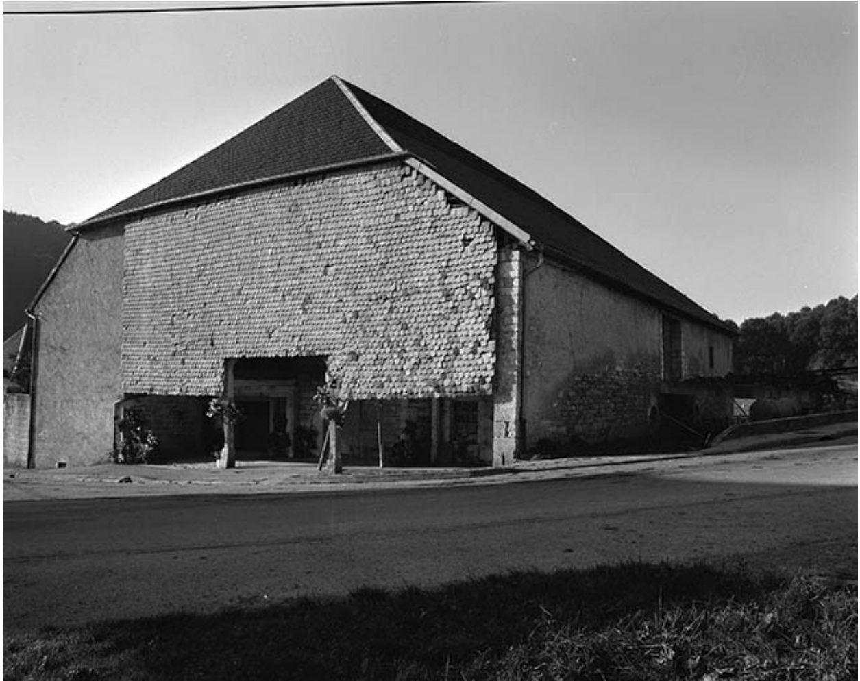
Façade latérale droite sur rue.
