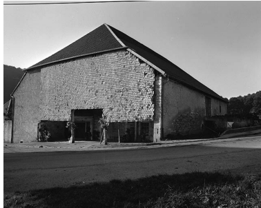
Façade latérale droite sur rue. Phot. Bernard Lardière IVR43_19782500311X
