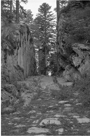
Passage taillé dans la roche pour la voie à ornières. Phot. Gilbert Poinot IVR43_19752500851Z
