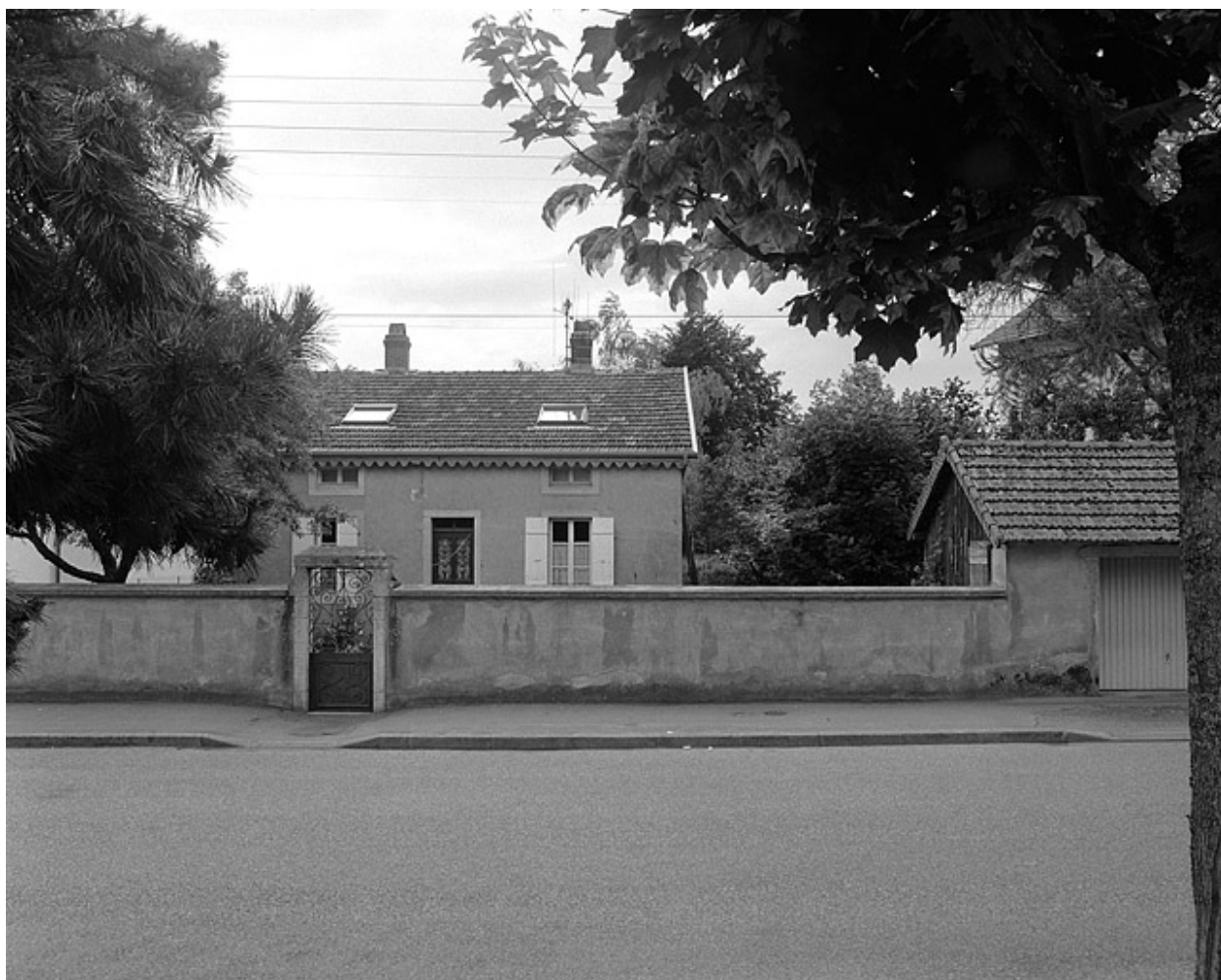
Vue d'ensemble depuis la rue.
