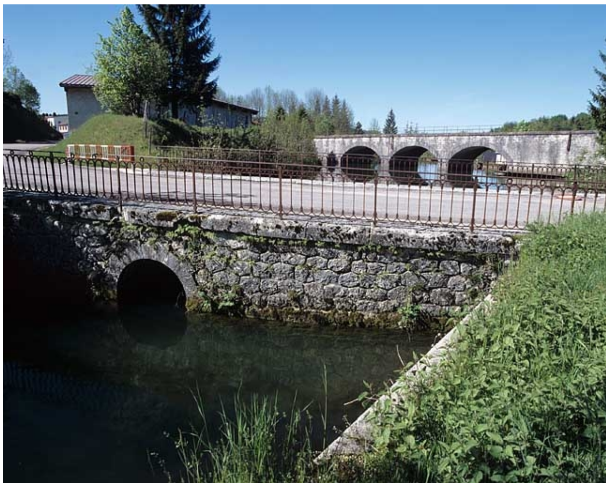
Pont ferroviaire et viaduc des Gaudards situés route Blanche.
