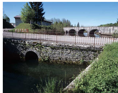
Pont ferroviaire et viaduc des Gaudards situés route Blanche. Phot. Yves Sancey IVR43_20053900311XA
