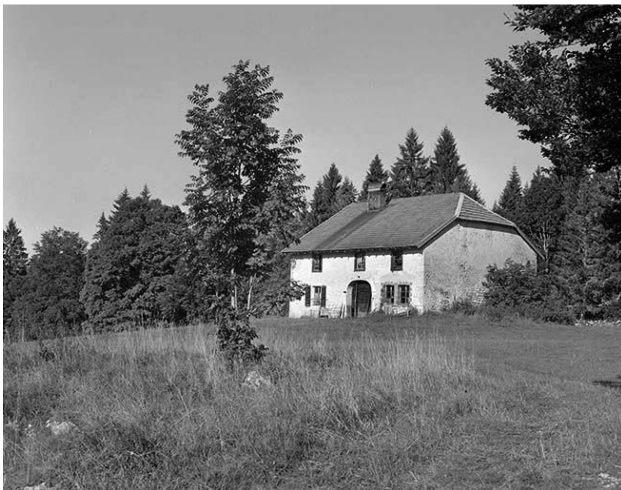
Ferme située au lieudit Le Haut de la Combe.
