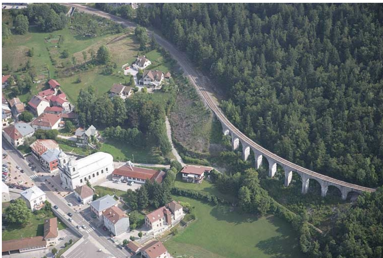
Viaduc de Morbier situé au lieudit Le Bois des Crottes.
