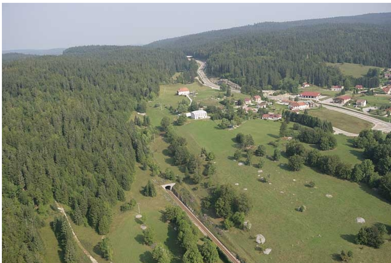
Tunnel dit souterrain de la Savine situé au lieudit Le Bois de la Savine.
