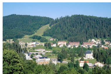
Usine d'estampage Gaudard. Phot. Laurent Poupard IVR43_19913901581ZA
